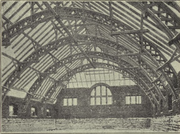
Abb. 24 Reithalle des Kgl. Landgestüts in Marienwerder
