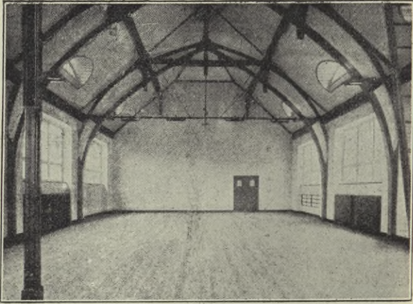
Abb. 30 Turnhalle Kepplerstraße in Essen a. Ruhr
