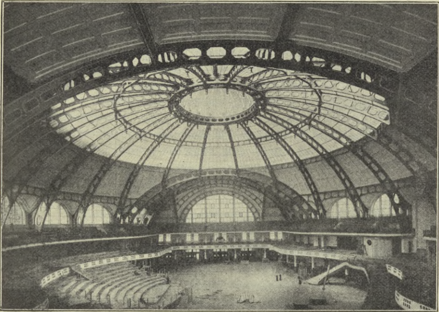
Abb. 43 Festhalle in Frankfurt a. M. Architekt: Friedr. v. Thiersch, München (Aus: „Der Baumeister“, Verlag Georg D. W. Callwey, München)
