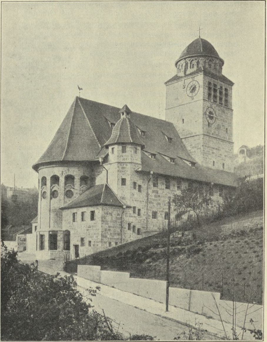
Abb. 70. Erlöserkirche in Stuttgart. Architekt: Prof. Dr. Theodor Fischer in Stuttgart (Aus: „Architektonische Rundschau“, Verlag J. Engelhorn, Stuttgart)
