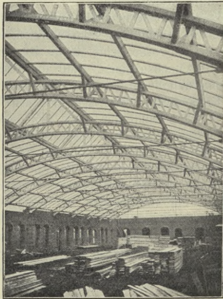
Abb. 23 Werkstätten F. Soennecken, Bonn, 3 Hallen 18 \times 60 m (Ausgeführte Dachstühle der „Gesellschaft für Ausführung freitragender Dachkonstruktionen in Holz, „System Stephan“, G. m. b. H., Düsseldorf“)
