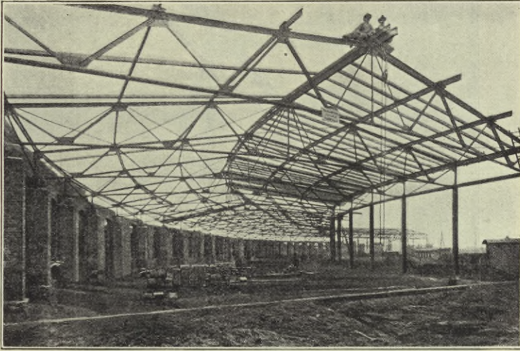
Abb. 37 Lokomotivschuppen der Königl. Eisenbahn-Bauabteilung Rheydt
