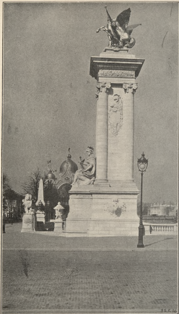
PYLÔNE AVAL RIVE GAUCHE VU DU PONT.
