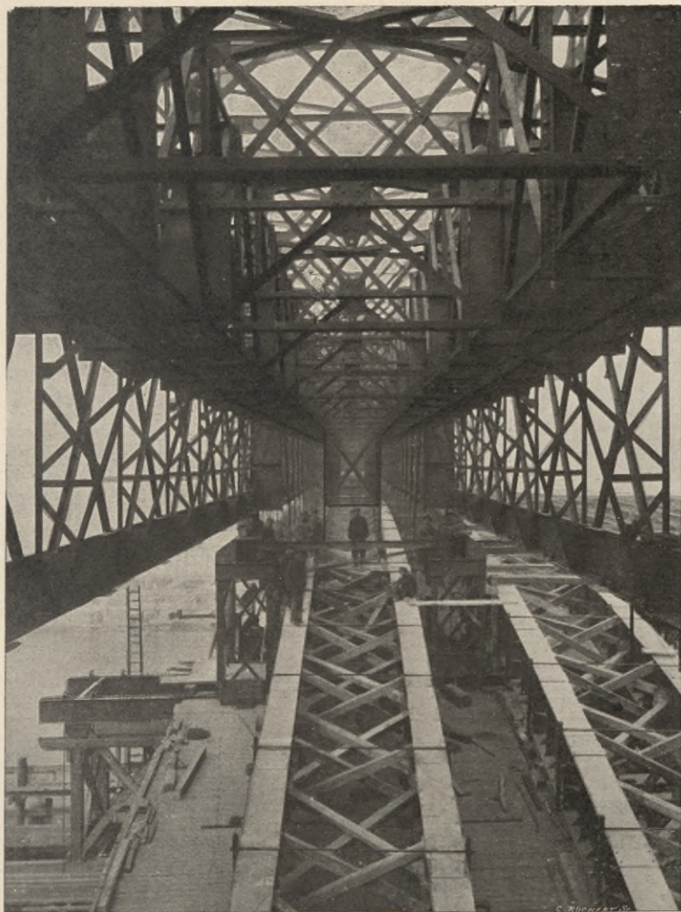
CONTREVENTEMENT PROVISOIRE DES ARCS.
