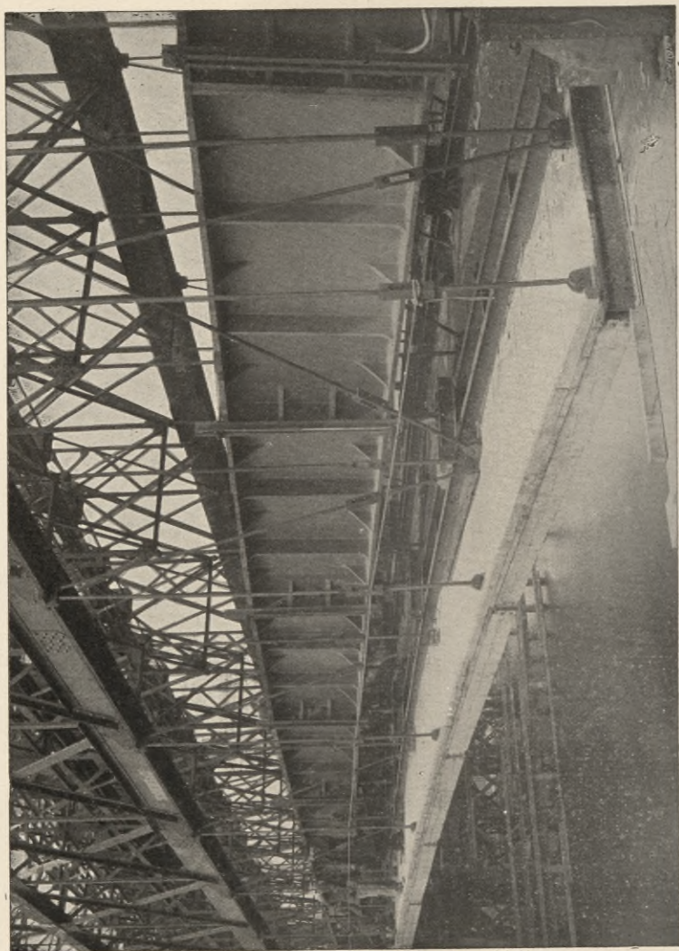
FRAGMENT D'ARC SUR VÉRINS AVANT LE DÉCINTREMENT.
