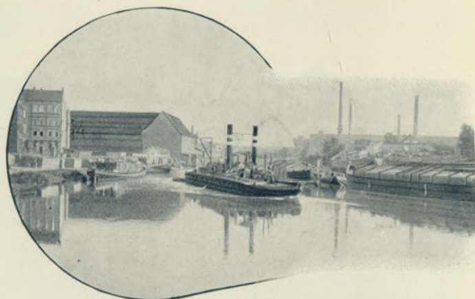
Halle a. S., Ladestelle an der Schieferbrücke.
