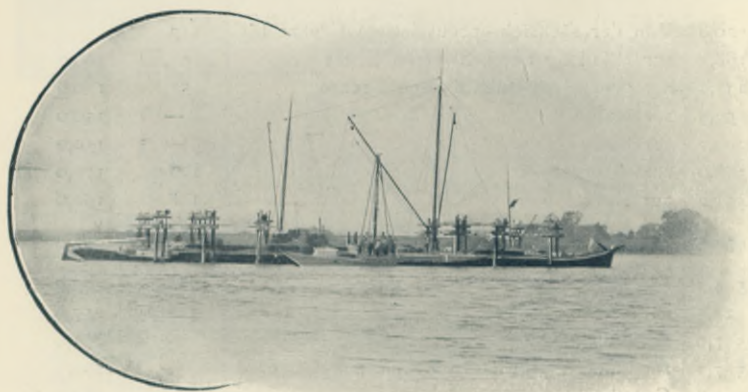
Hebung eines gesunkenen Elbkahns.
