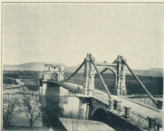
Weserbrücke bei Oldendorf.
