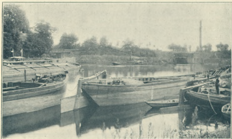
Unterwasser der Schleuse bei Fürstenwalde.
