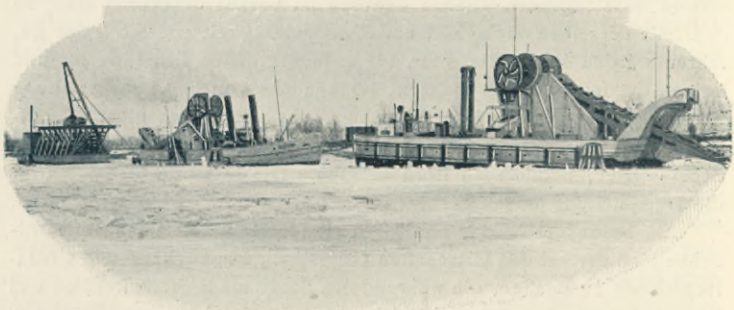
Bagger im Eise am Königsberger Seekanal.
