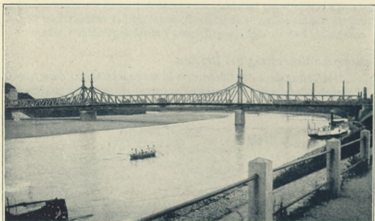
Neue Strassenbrücke bei Ohlau.
