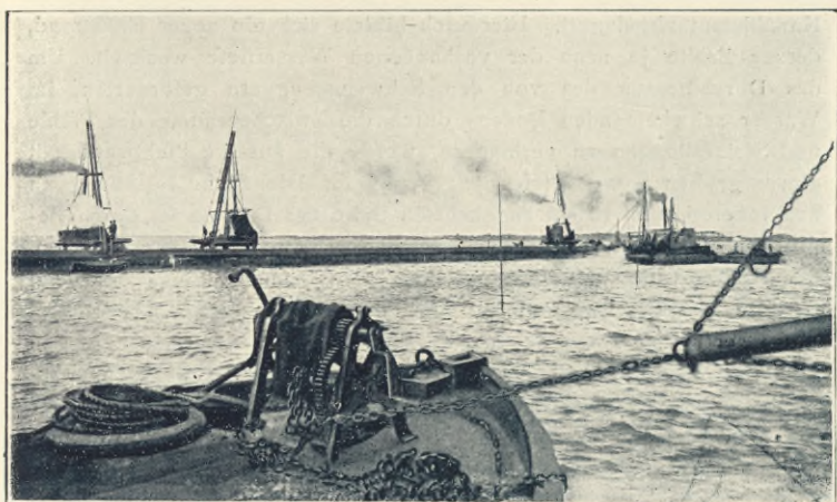
Königsberger Seekanal, Bau der Kanaldämme.
