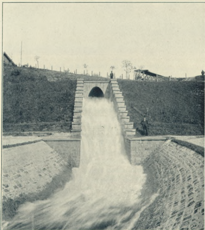
Kaskaden-Auslass am Emsübergang.
