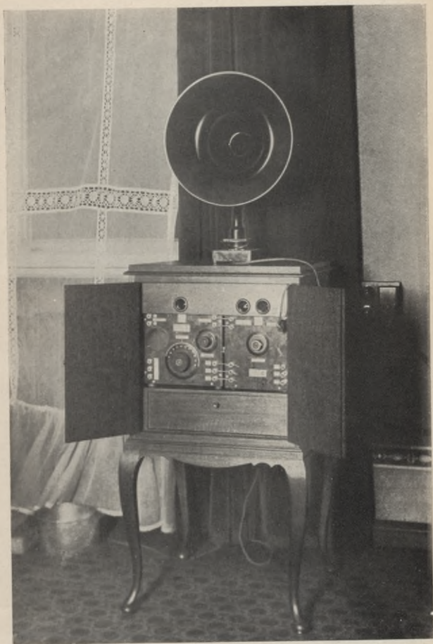
Tafel XVI. Telefunken-Rundfunk-Empfänger mit Niederfrequenz-Verstärker. (Luxusausführung.)
