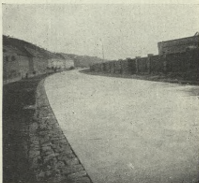
Abb. 40. Solidität-Betonstrecke auf der ehemaligen Militär-Ringstraße zu Köln.
