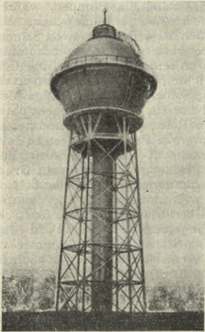
Fig. 82. Wasserturm in Eisenbau.
