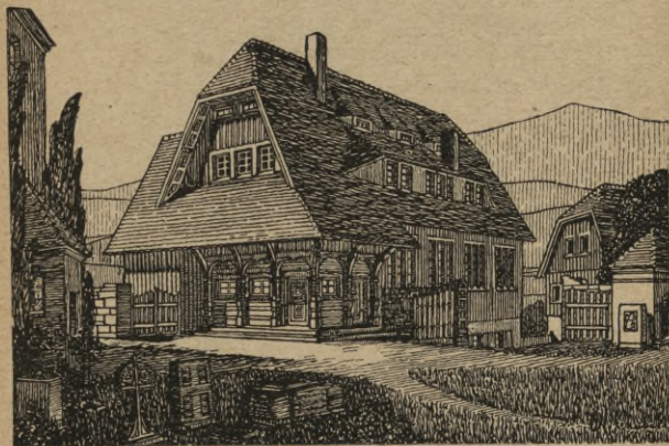
Abb. 33. Pfarramt mit Konfirmandensaal und Wohnung des Hilfsgeistlichen zu Sohland a. d. Spree.
