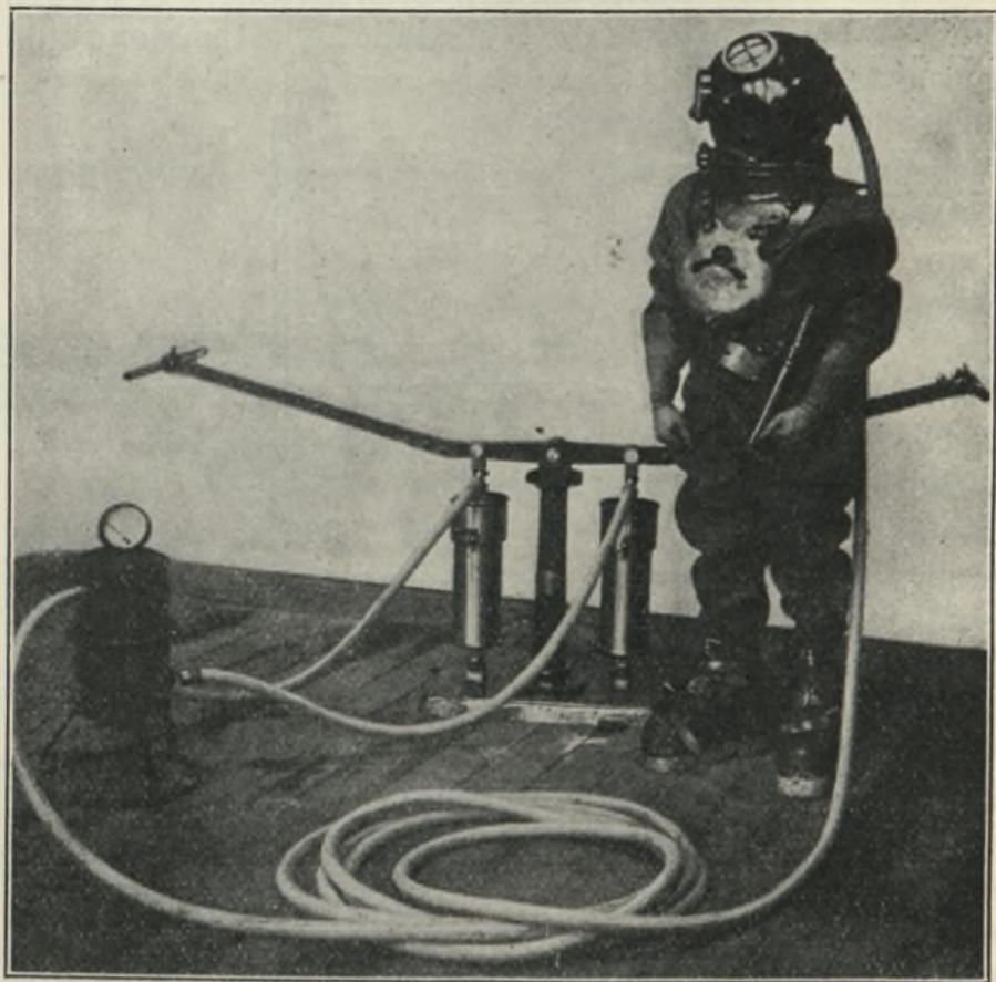
Abb. 34. Druckluft-Taucherrüstung.
