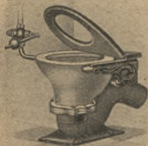
Abb. 60. Spülhahn im Spülrohr.
