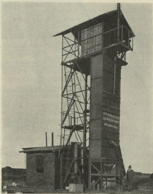
Abb. 60. Torfverkokungssofen. System Steinert. Torfwerk Kaltenkirchen in Holstein.
