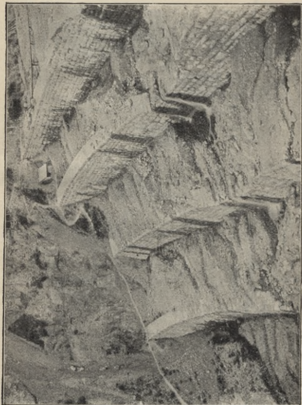
Abb. 84. Oberste Sperren der Scesa bei Bludenz (Vorarlberg).
