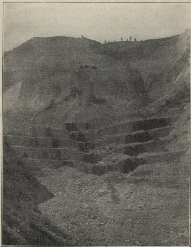
Abb. 83. Oberste Sperren und Abbruchsgebiet der Scesa bei Bludenz (Vorarlberg).
