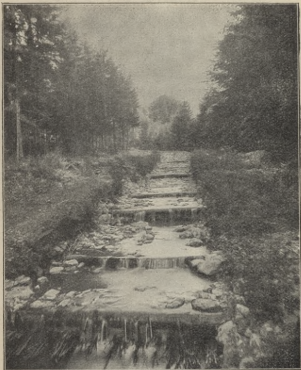
Abb. 100. Schale mit Abstürzen aus Holzschwellen und Faschinensturzbett.
