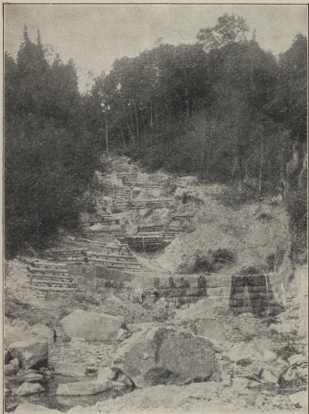
Abb. 95. Steinkastenbauten in der Dornbirner Ache.
