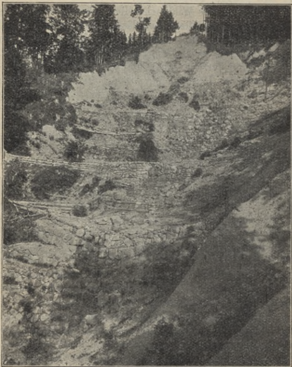
Abb. 77. Oberstes Einzugs- und Abbruchgebiet des Kapellenbaches bei Immenstadt mit seinen Verbauungen.
