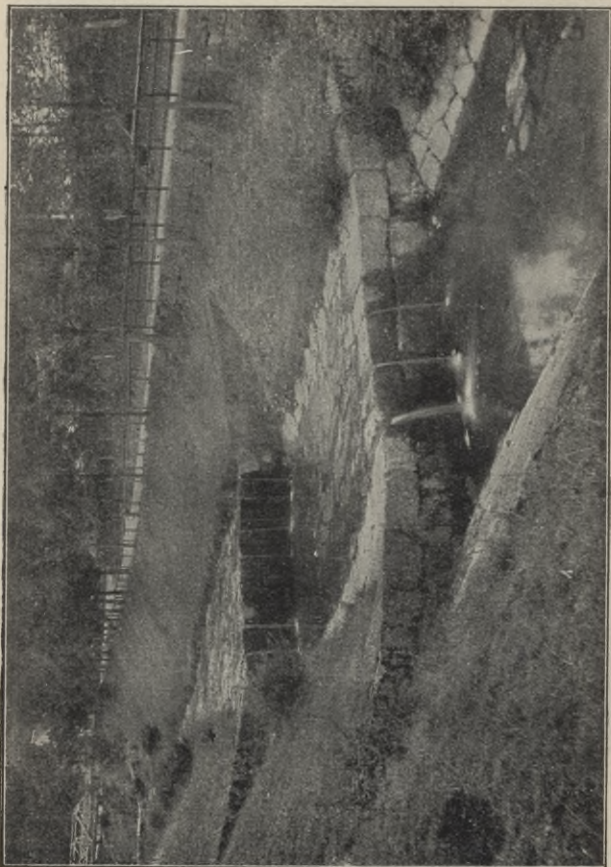
Abb. 99. Schale mit stufenartigen Abstürzen aus Stein.
