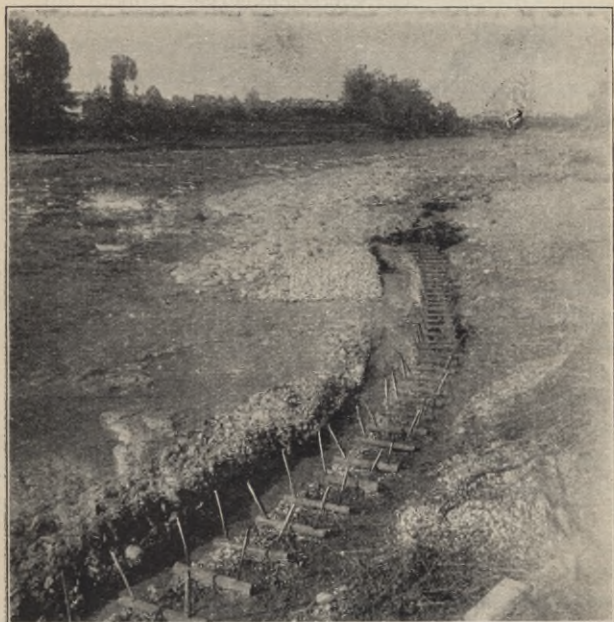
Abb. 10. Anfertigung von Senkwellen. Faschinenbank.
