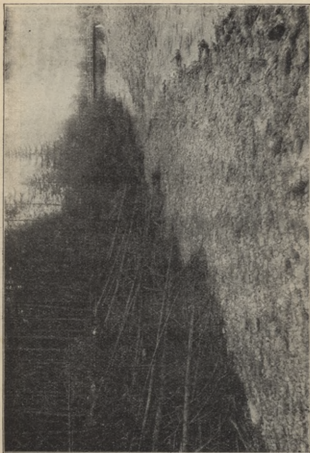
Abb. 22. Provisorischer Uferschutz mit Raubbäumen.
