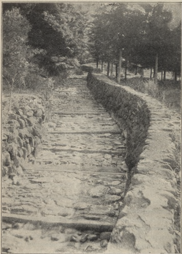
Abb. 98. Trapezförmige Schale mit Sohlenpflaster und Holzschwellenfixierung.
