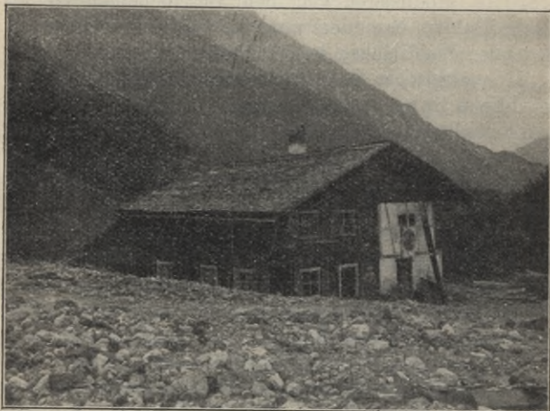
Abb. 79. Verschüttung eines Hauses bis zu halber Höhe mit Geröllmassen.
