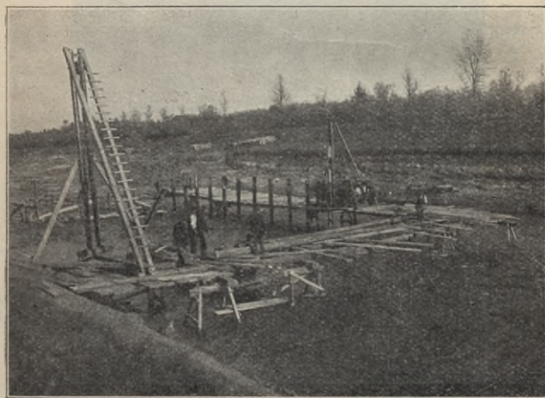
Abb. 74. Herstellung einer Sohlenschwelle in der Iller bei Egelsee. Erster Teil.
