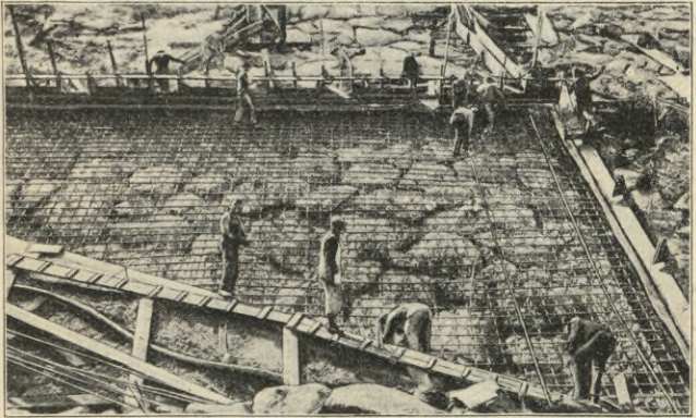
Abb. 81. Salt-Springs-Damm. Herstellung der Dichtungsplatte.
