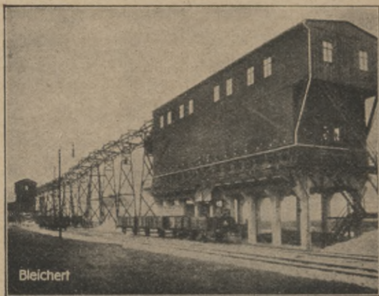
Fig. 129. Verladetaschen mit Bleichertschen Klappverschlüssen zur Verladung von Massengütern in Fuhrwerke, Eisenbahnwagen und Schiffe.
