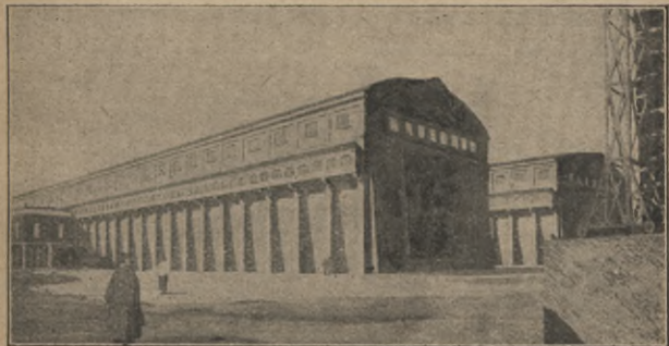
Fig. 133. Speicher für Kalisalze.
