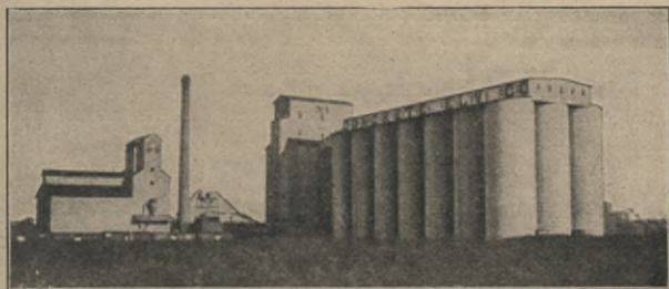
Fig. 101. Betonsilo der Concrete Elevator Co. in Minneapolis. (Aus Zt. „Mühlen- und Speicherbau“.)
