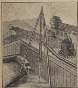
Abb 43. Pulsometer in einer Baugrube.
