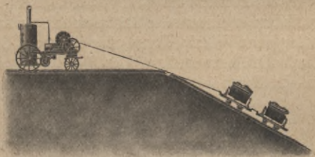
Abb. 27. Baulokomobile beim Aufziehen von Wagen auf schräger Bahn.
