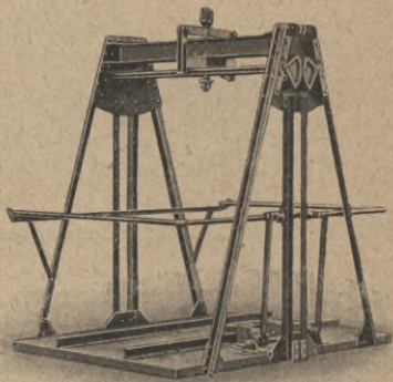
Abb. 18. Fahrstuhl für Bauaufzüge:
