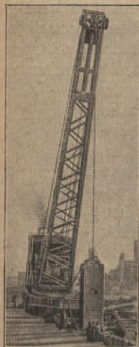
Abb. 104. Pfahlhammer in Tätigkeit.
