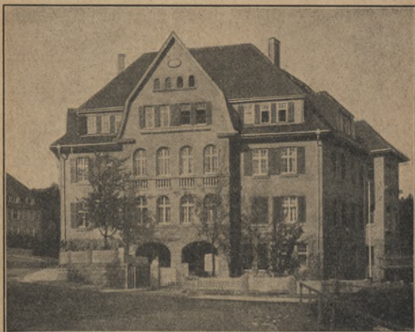
Abb. 32. Haus an der Lenzhalde, Stuttgart. Arch.: Alfred Storz, Stuttgart. (Der Baumeister. Georg D. W. Callwey, München.)
