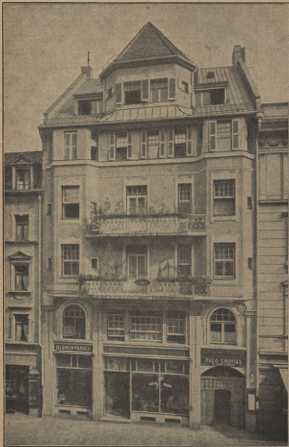
Abb. 34. Haus Augustenstraße 54, München. Arch.: Gebr. Rank, München. (Geßner, Das deutsche Miethaus. F. Bruckmann A.-G., München.)
