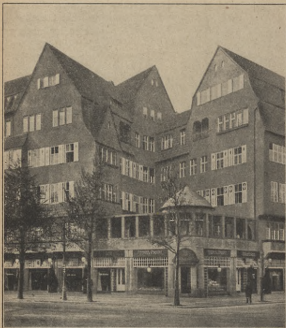
Abb. 47. Eckpartie des Hauses Bismarckstraße 109, Charlottenburg.
