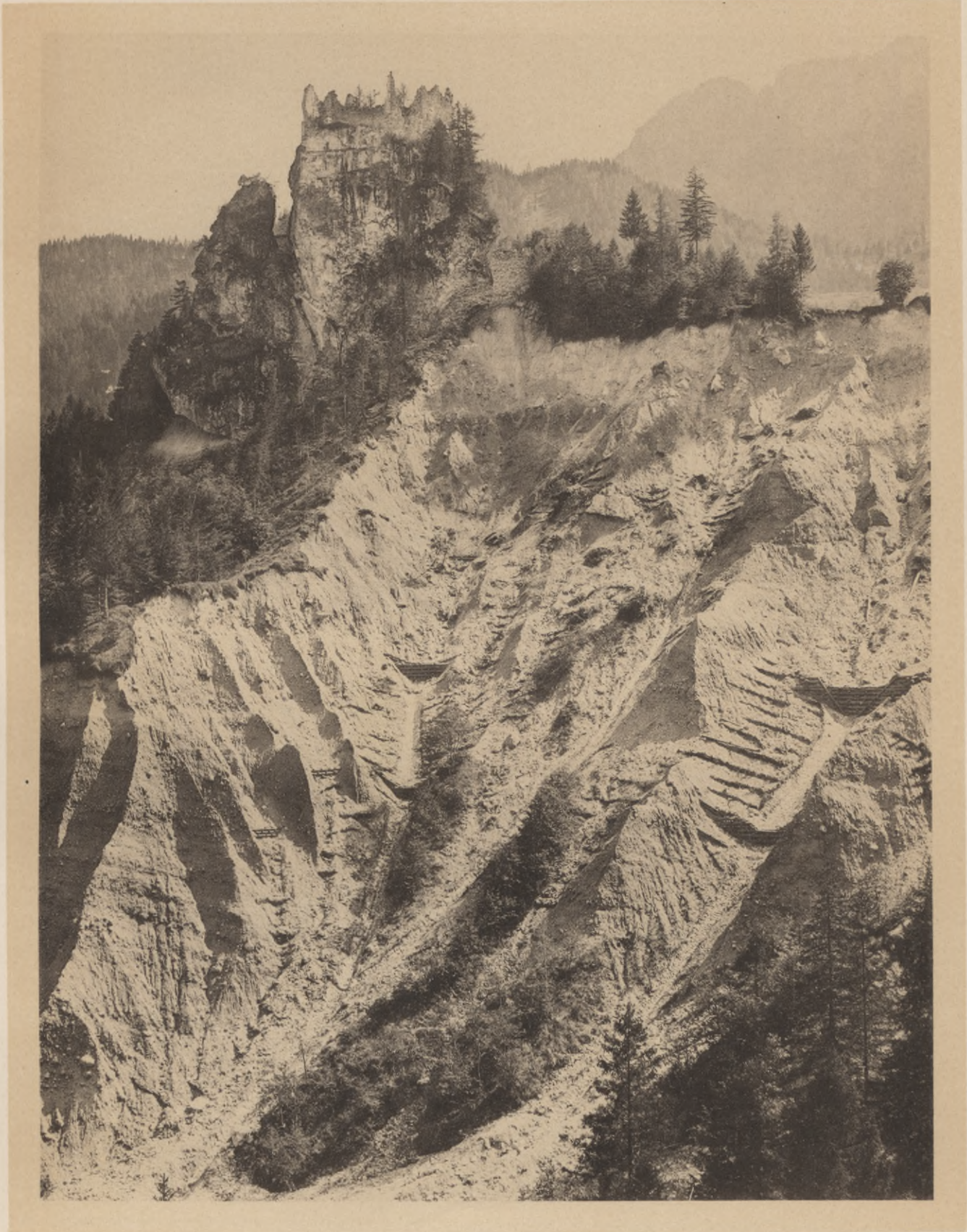
Verbauung einer Bruchlehne im Val Canali.
