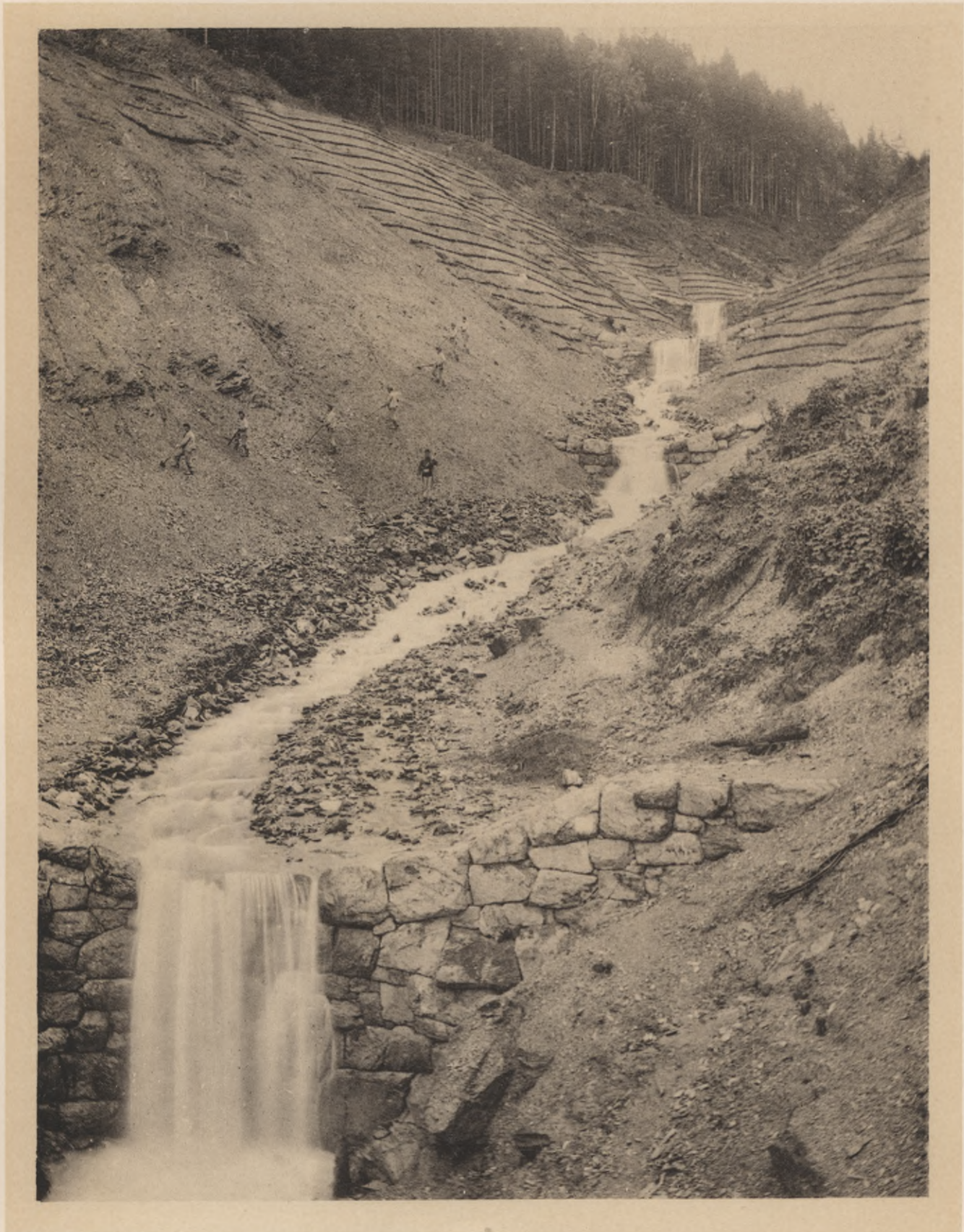
Sohlen- und Lehnensicherungen im Lichtmessbache bei Admont.
