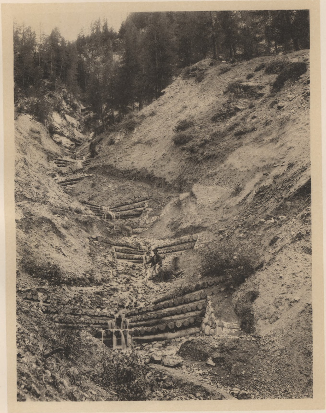
Runsenverbauung im Falkungraben.
