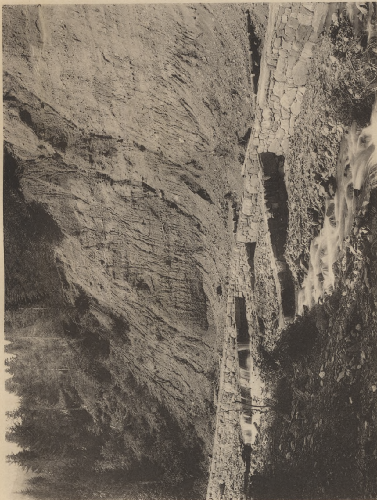
Leitwerk mit Grundschwellen im Sifitzgraben.
