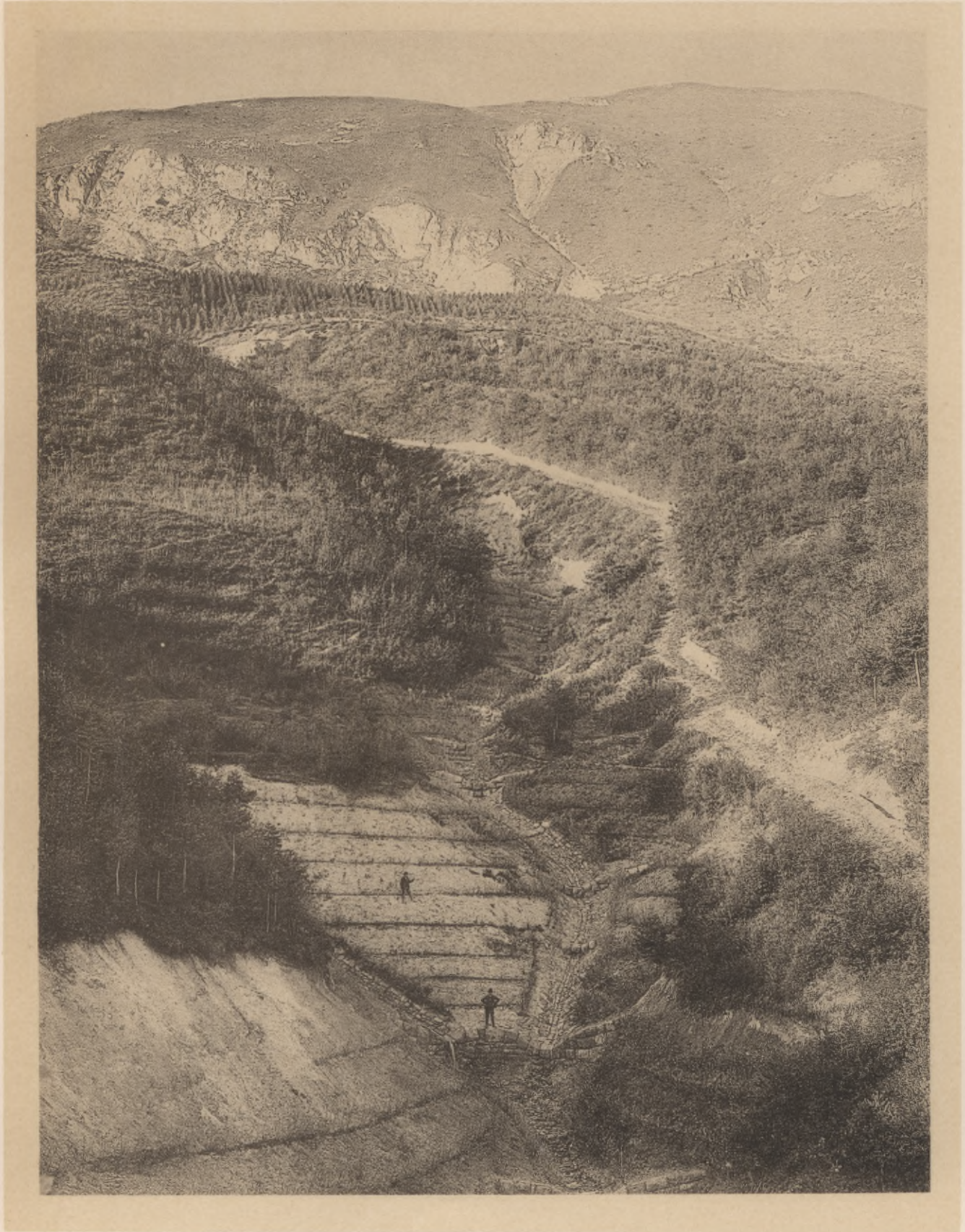
Verbauungen und Aufforstungen im oberen Gebiete des Sornellbaches.
