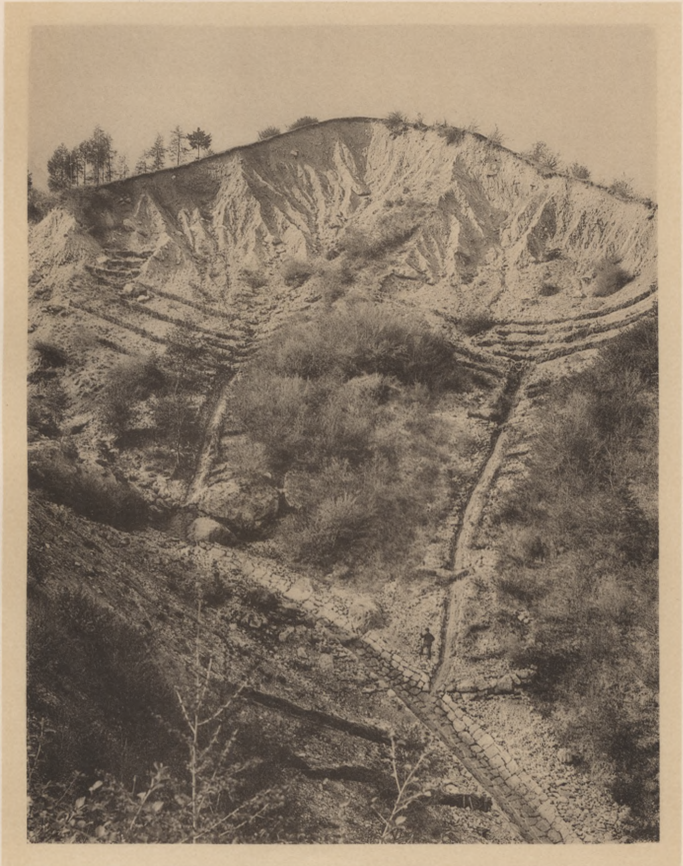
Verbauung einer Bruchlehne im Rivo Lazer.
