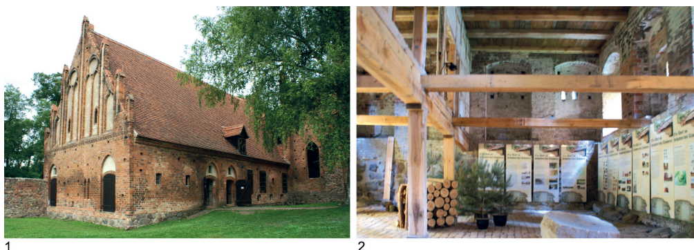
Fig. 9. Brewery in Chorin: 1 – south wall, 2 – interior, 2009, photo by E. Łużyniecka
