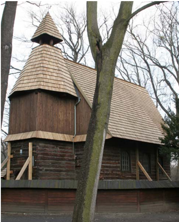
Ryc. 1. Budynek kościoła w trakcie ostatniego remontu. Fotografia z 2015 roku
