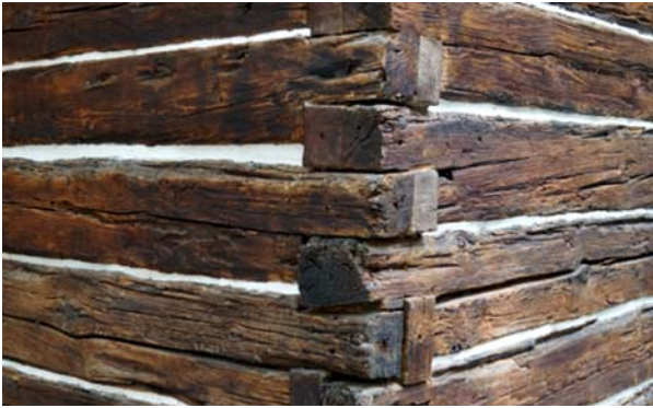
Ryc. 7. Połączenie w narożu ścian prezbiterium przed (zdjęcie górne) i po renowacji (zdjęcie dolne)
