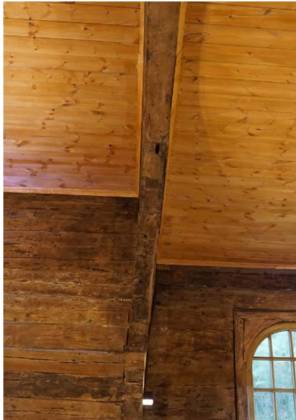
Ryc. 9. Deformacja łuku tęczowego. Widoczne wewnętrzne słupy mocowane do ścian przed renowacją (zdjęcie z lewej strony). Widok po renowacji na zdjęciu z prawej strony
