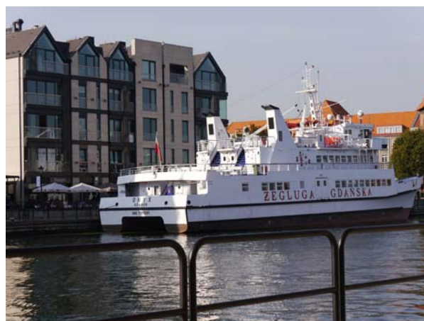
Ryc. 2. Apartamentowiec Symfonia Residence, widok od Motławy – elewacja wschodnia, fot. Jacek Gyurkovich
