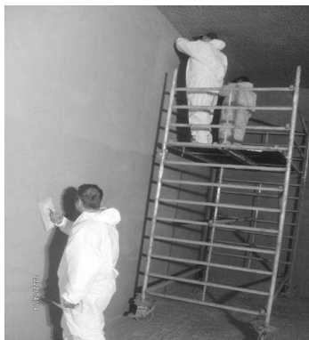
Fot. 5a), b) Prace wykończeniowe. Ręczne zacieranie i wygładzanie powierzchni ścian komory zbiornika
