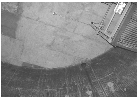
Fot. 1a), b), c), d) Stan betonowych powierzchni wewnątrz żelbetowej komory zbiornika przed podjęciem działań remontowych
