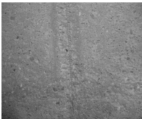
Fot. 2a), b) Czyszczenie strumieniowo-ścierne wszystkich powierzchni betonowych poszczególnych elementów komory zbiornika
