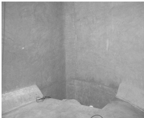
Fot. 8a), b) Stan ścian i płyty dennej zbiornika po modernizacji
