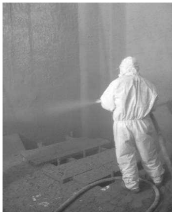
Fot. 4a) i b) Prace doszczelniające wewnętrznych powierzchni zbiornika żelbetowego
