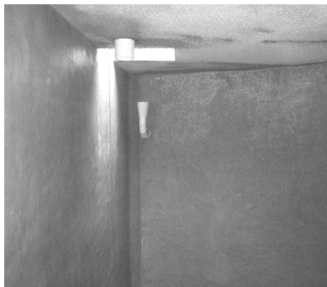
Fot. 7a), b) Stan płyty stropowej po przeprowadzonej modernizacji z zastosowaniem systemu KERESAL®
