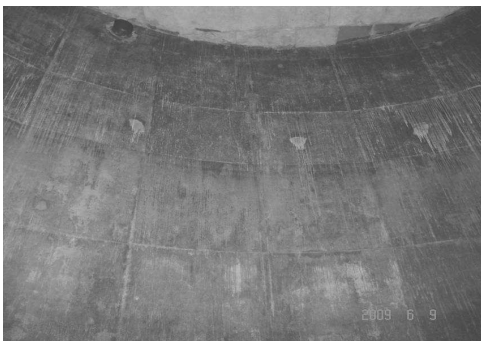
Fot. 1a), b), c), d) Stan betonowych powierzchni wewnątrz żelbetowej komory zbiornika przed podjęciem działań remontowych
