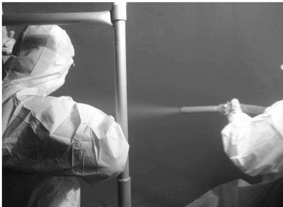
Fot. 4a) i b) Prace doszczelniające wewnętrznych powierzchni zbiornika żelbetowego
