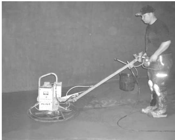
Fot. 6. Prace wykończeniowe. Mechaniczne zacieranie i wygładzanie powierzchni płyty dennej komory zbiornika
