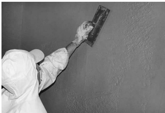
Fot. 5a), b) Prace wykończeniowe. Ręczne zacieranie i wygładzanie powierzchni ścian komory zbiornika
