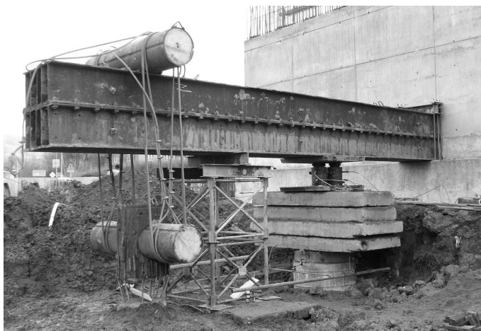
Fot. 1. Widok stanowiska do próbnych obciążeń kolumny kamiennej
