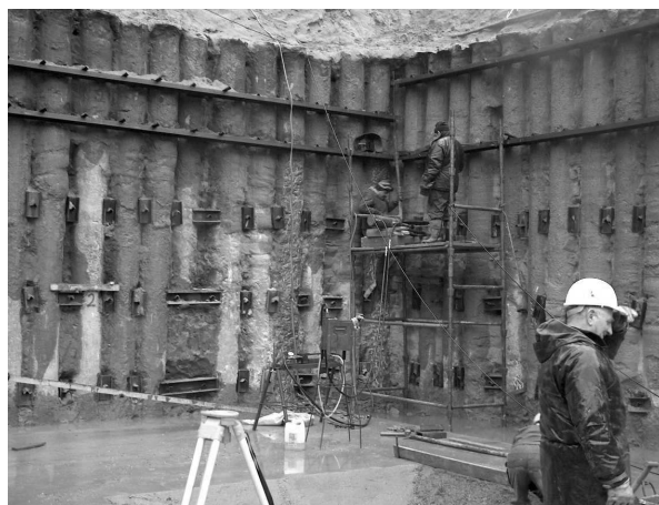
Fot. 1. Fragmenty gwoździowanego wykopu podczas pomiaru. Wykop zabezpieczono dodatkowo palami
