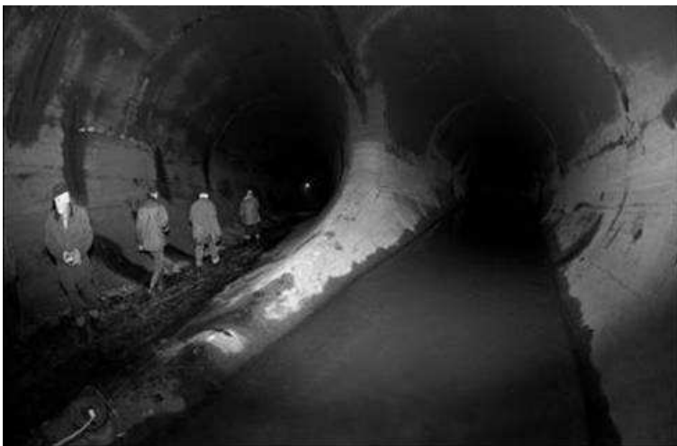
Fot. 1. Odwodnione sztolnie: energetyczna i spustowa [15]
