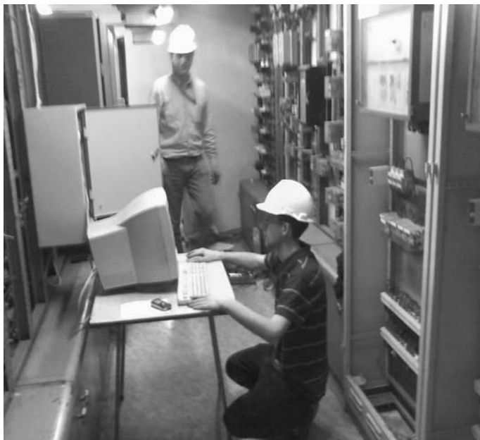
Rys. 8. Konfiguracja elementów rozproszonego systemu pomiarowego w pomieszczeniu sterowni Fig. 8. Configuration of distributed measuring system elements in control room
