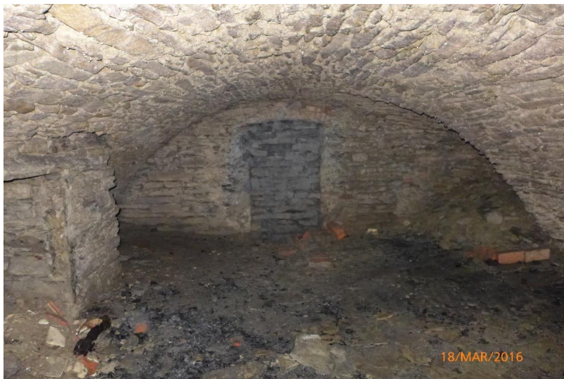
Rysunek 27. Ta sama piwnica w widoku na przeciwległą ścianę z widocznym kolejnym zamurowanym przejściem oraz wyjściem z piwnicy w kierunku rynku. Na zdjęcie widoczne zasypisko tego przejścia, którego relikty zostały odślonięte w czasie praktyk studenckich pod nadzorem dr archeologa Wojciecha Pasterkiewicza. Po lewej stronie na pierwszym planie typowe dla dukielskich piwnic podmurowanie sklepienia o niezidentyfikowanej funkcji, która nie jest związana ze wzmocnieniem sklepienia. Fot. autor 2016 r.
