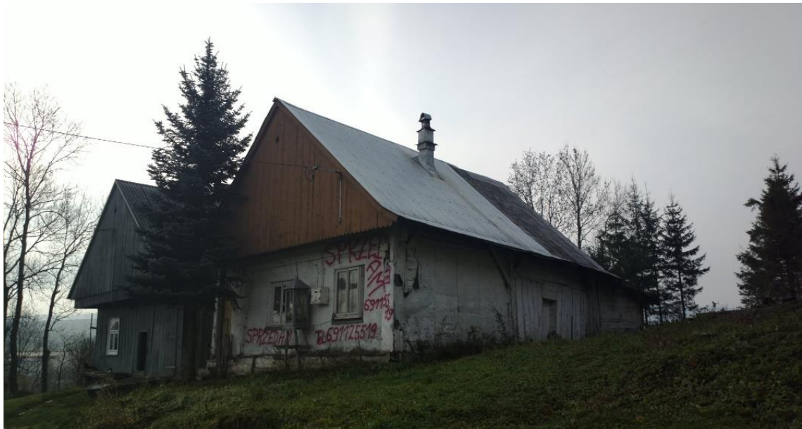
Rysunek 61. Dwa interesujące przykłady starej substancji budowlanej w Jaśliskach. Domy przy ulicy Wolańskiej – dom po lewej posiada sień przejazdową i dwutraktowy układ wnętrza, dom po prawej oddzielony od pierwszego szerokim na ok. 2,5 metra międzuchem otwartym, ma dwa i pół traktu konstrukcyjnego. Rozwiązanie półtraktu jest oparte o podcień narożny (obecnie zabudowany) i przejście wzdłuż całej długiej elewacji kończące się zrujnowaną przybudówką. Możliwe, że wspomniany półtrakt jest pozostałością po sieni przejazdowej, która ograniczała rozpiętość międzucha nakrywając go przy okazji okapem. Fot. autor 2016 r.
