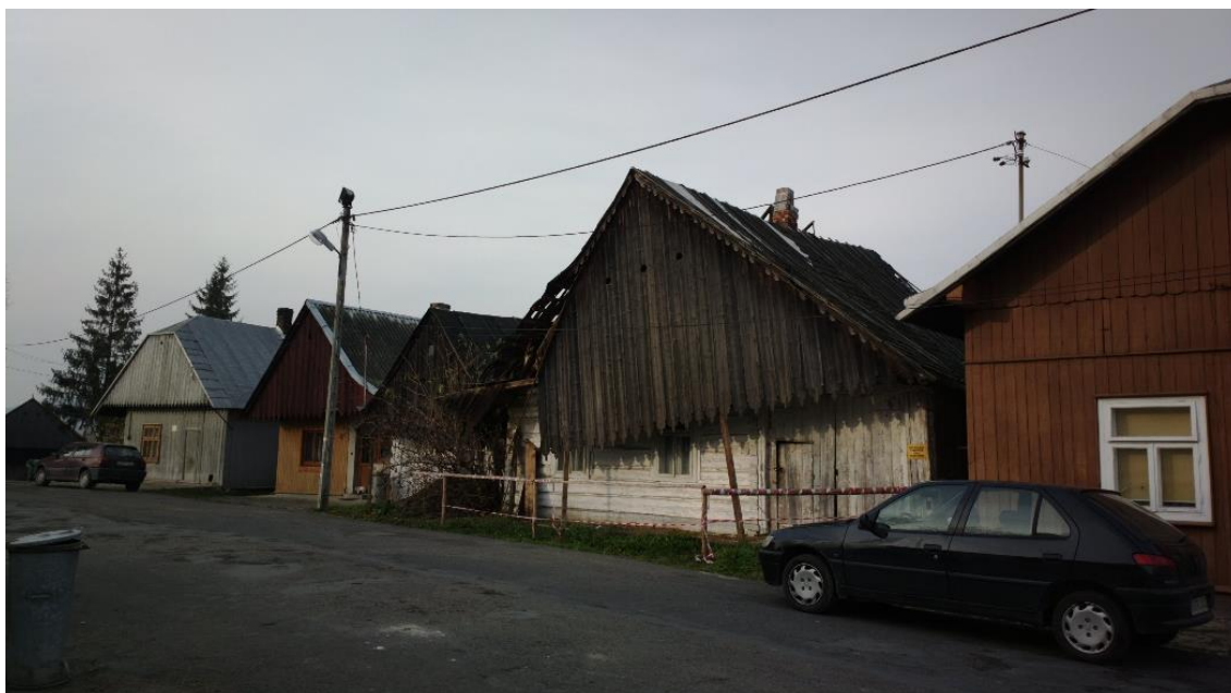
Rysunek 58. Ta sama pierzeja z widocznym zrujnowanym domem nr 28 - ostatnim trójtraktowym domem zajezdnym (przejazdowym), rozebrany w momencie otwarcia przewodu doktorskiego autora . Fot. autor 2015 r.
