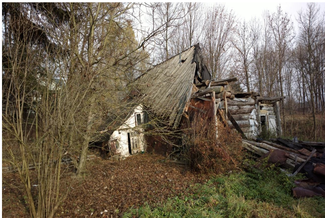
Rysunek 81. Ruiny dużego, trójtraktowego domu przy ulicy Wolańskiej. Fot. autor 2015 r.
