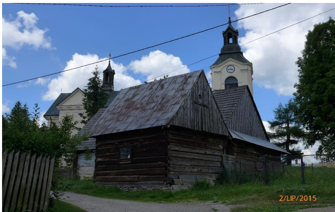
Rysunek 64. Ta sama zagroda widziana od strony zapleczewej, zwraca uwagę pokrycie dachu blachą na rąbek stojący, która prawdopodobnie została pozyskana z innego budynku, który został rozebrany (na blasze są słabo czytelne nadruki „made in America”). Fot. autor 2015 r.
