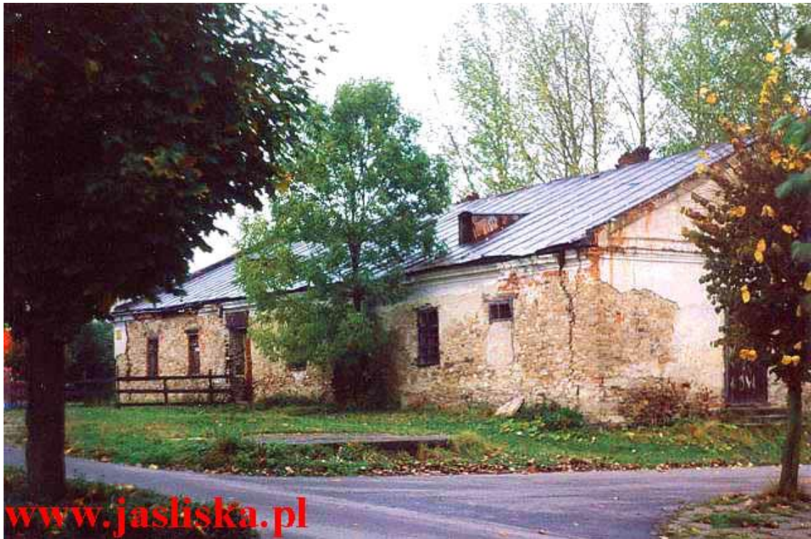
Rysunek 106. Jedna z ostatnich fotografii ratusza przed rozbiórką. Źródło: witryna internetowa www.jasliska.pl [Dostęp 18 04 2015 r.].
