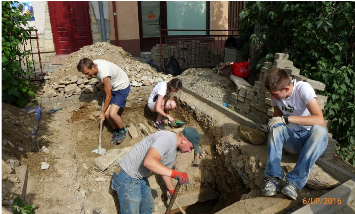
Rysunek 35. Praktyka studencka w rynku w Dukli prowadzona pod kierunkiem autora opracowania i nadzorem dr archeologa Wojciecha Pasterkiewicza. Widoczne odstąpięte sklepienie piwnicy przedprozowej na głębokości 40 cm poniżej poziomu terenu. Na zdjęciu zespół studentów Zakładu Budownictwa PWSZ w Krośnie przy sondowaniu zewnętrznego wejścia do piwnicy. Fot. autor 2016 r.
