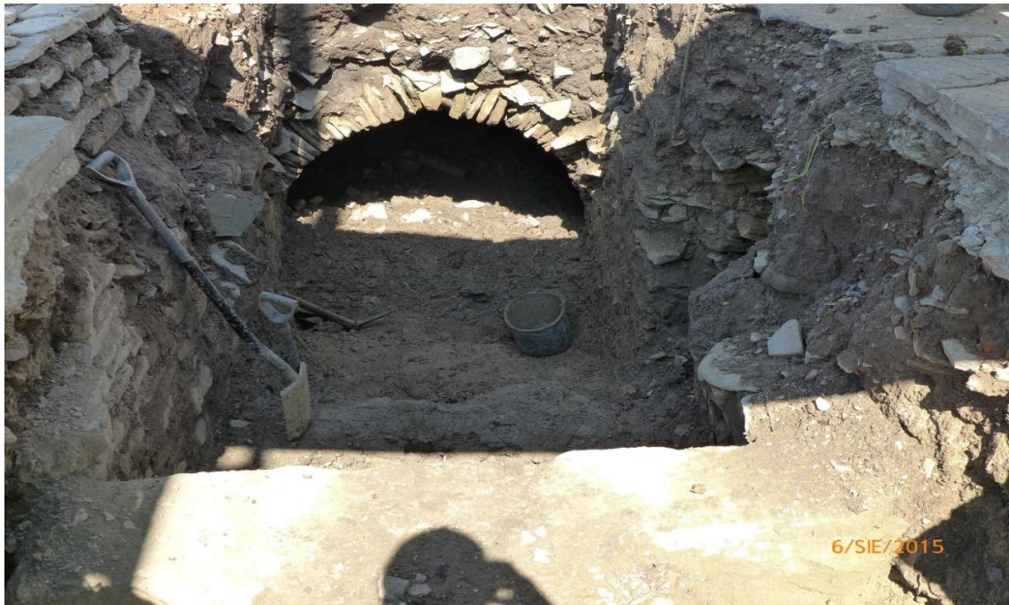
Rysunek 33. Sklepienie przedsionka piwnicznego widocznego na rys. 31. Pod betonową płytą widoczną na pierwszym planie odkryto dwa schody prowadzące do piwnicy w trakcie drugiej eksploracji w 2016 r. Fot. autor, 2015 r.
