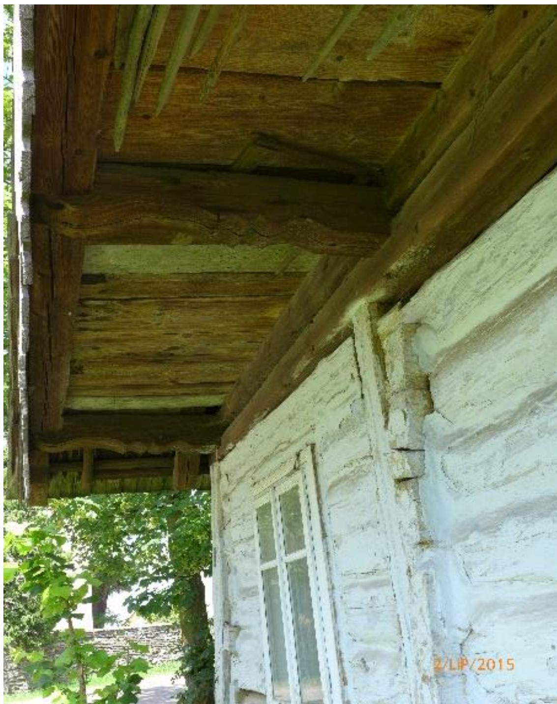
Rysunek 43. Podcienia nadwieszane w chałupie nr 126 w Jaśliskach. Fot. autor 2015 r.
