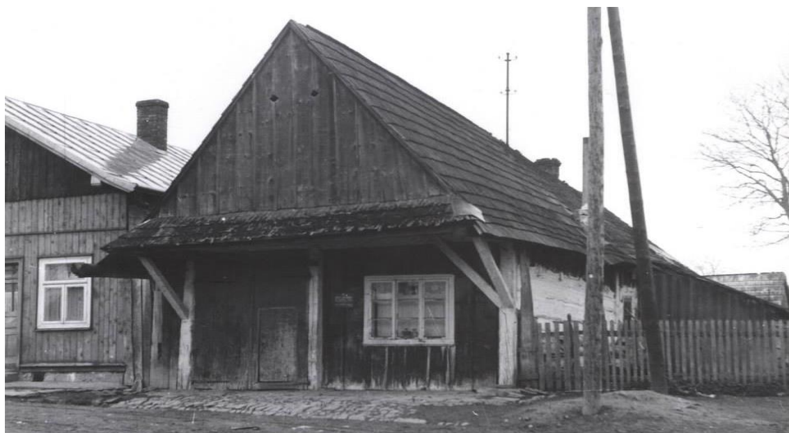
Rysunek 56. Widok na fragment zachodniej pierzei rynku w Jaślikach z podcieniowym domem drewnianym z połowy XIX wieku, rozebrany około 1965 roku (wg oświadczenia Stanisława Lorenca – lokalnego przewodnika turystycznego i byłego nauczyciela). Budynek po rozbiórce został przeniesiony do skansenu w Sanoku, gdzie nie doczekał się ponownego złożenia. Ostatecznie został zrekonstruowany w zespole zabudowy małomiasteczkowej w XXI wieku. Źródło: Wojewódzki Urząd Ochrony Zabytków w Przemyślu Delegatura w Krośnie, Rep. autor 2016 r.
