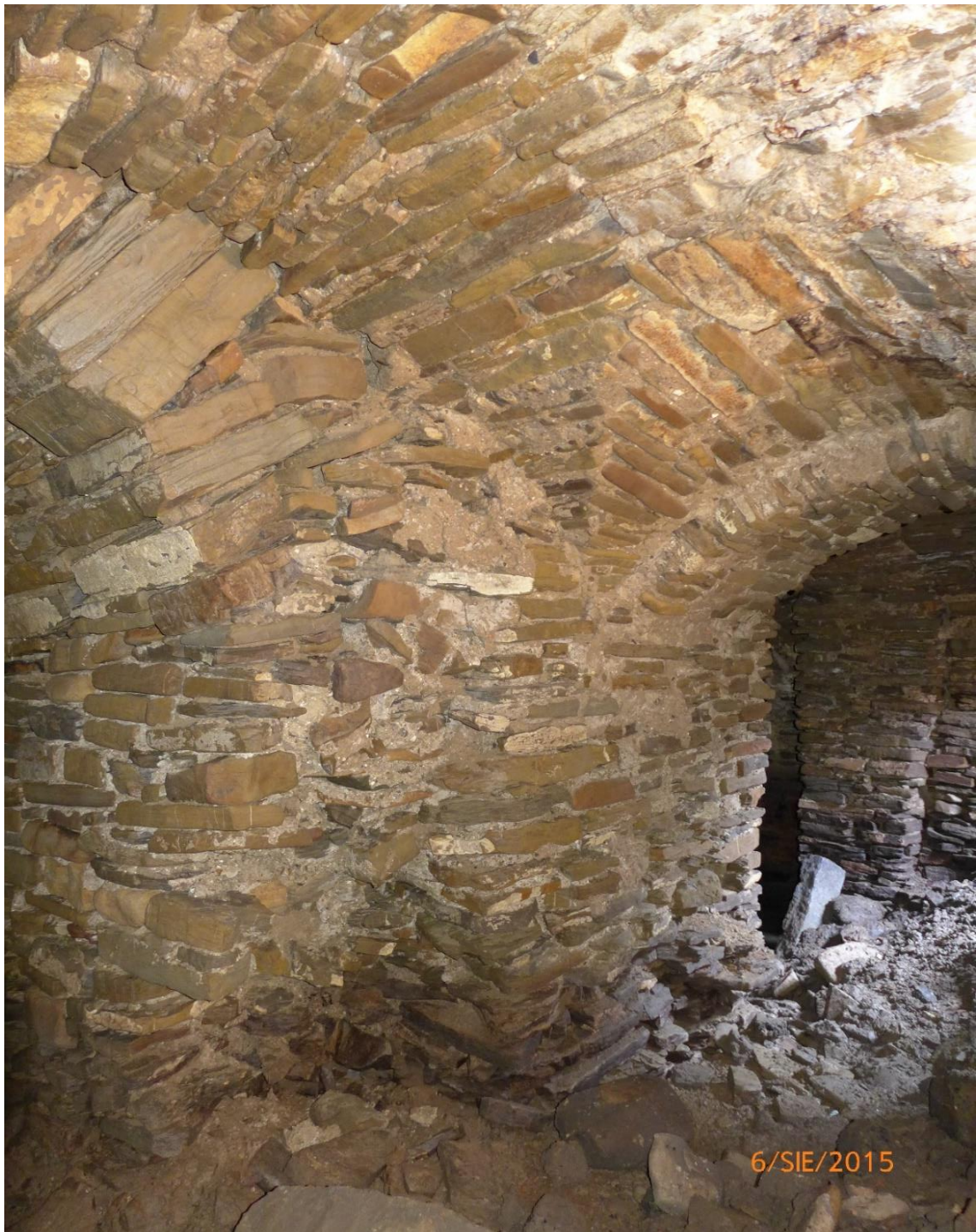
Rysunek 32. Fotografia przedstawia interesujący fragment narożnika ściany piwnicznej w miejscu łączenia się komór piwnicznych pokazanych na rysunku nr 31. Widoczne przejścia wielokierunkowe i tęg sklepienia kolebkowego. Fot. autor w okresie pierwszej eksploracji w 2015 r.
