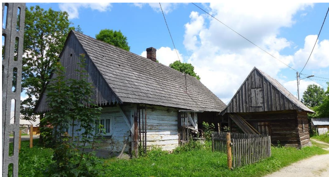
Rysunek 63. Wg legendy na fotografii przedstawione najstarszą zachowaną do dziś chatupę zagrodową w Jaśliskach. W rzeczywistości budynek nosi ślady licznych przebudów i remontów. Archaiczna i unikatowa w skali Jaślisk rama przystępowa sprawia wrażenie najstarszego elementu budynku na równi z przyziemem części inwentarskiej, która wyraźnie została podniesiona o kilka belek. Interesujące jest jedyny kompletny kryty miedzuch łączący oba budynki. Fot. autor 2015 r.
