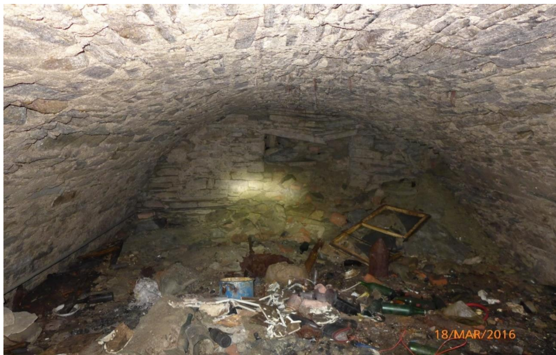
Rysunek 26. Fotografia piwnicy przechodniej, prawdopodobnie przedprożowej w Dukli. Długość piwnicy 7,5 m, szerokość 4,5 m. Widoczne zamurowanie przejścia do kolejnej piwnicy w ciągu pierzei zachodniej z załamaniem nadprożem kamiennym. Fot. autor 2016 r.
