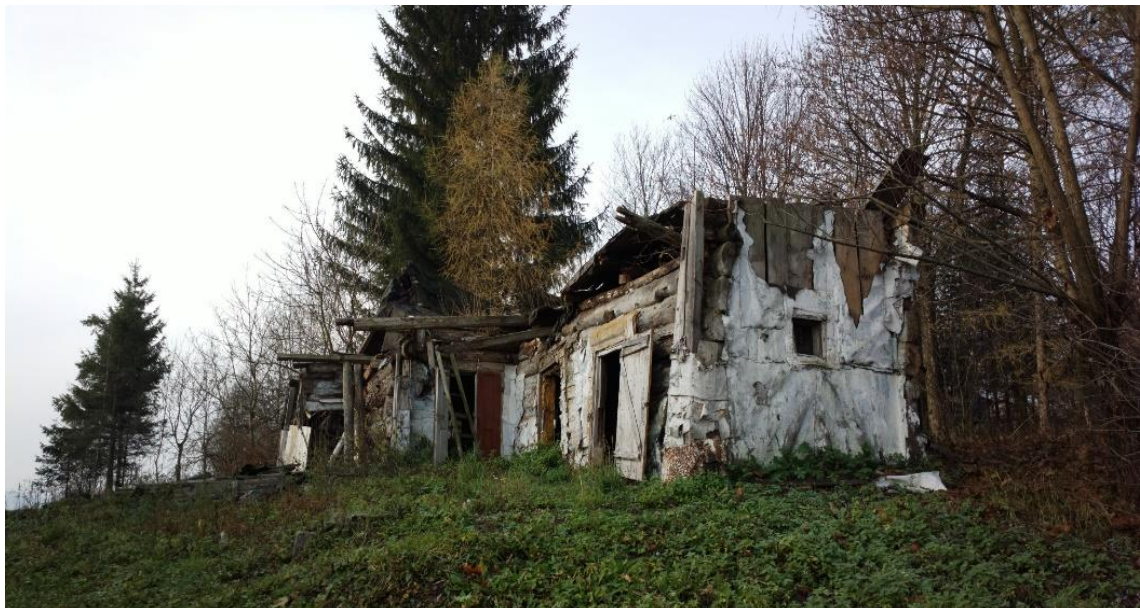
Rysunek 62. Ruina domu wąskofrontowego wg wywiadu z mieszkańcami pochodzącego z XVIII wieku. Duży, szeroki na ponad 8,0 m i długi na przeszło 15 m obiekt nosi ślady nadbudowania i zmian konstrukcyjnych, a elementy łączeń ciesielskich są bardzo zaawansowane. Pod budynkiem zachowały się niedostępne piwnice o znacznej długości. Prawdopodobnie miejsce po sieni przejazdowej (niepodpiwniczonej) kończy się identycznym jak w domu na rys. nr 60 destruktem komory gospodarczej. Fot. autor 2016 r.
