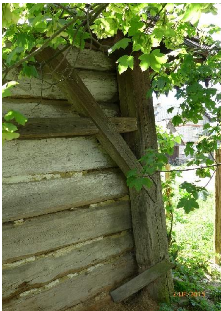
Rysunek 79. Północno-zachodni narożnik chałupy nr 126 z widocznym słupem zasadniczej konstrukcji posadowionym na niezależnym od niego drewnianym cokole. Fot. autor 2015 r.
