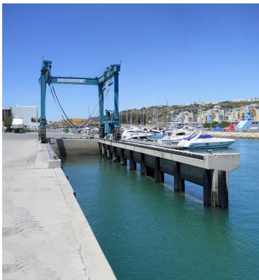
Rys. 3.65. Bramownica samojezdna (travelift) w części serwisowej. Źródło: autor
