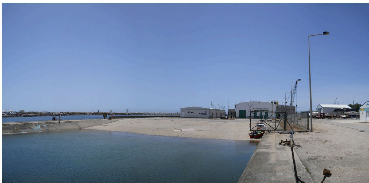
Rys. 4.36. Szeroki slip do obsługi jednocześnie dużej liczby małych jednostek. Źródło: autor
