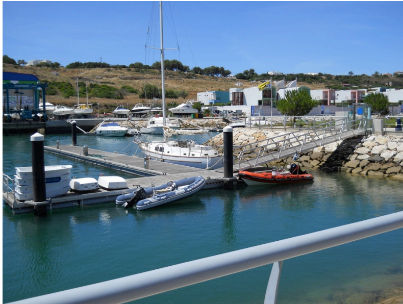
Rys. 4.25. Nabrzeże oraz przyłączony pirs pływający. Źródło: autor
