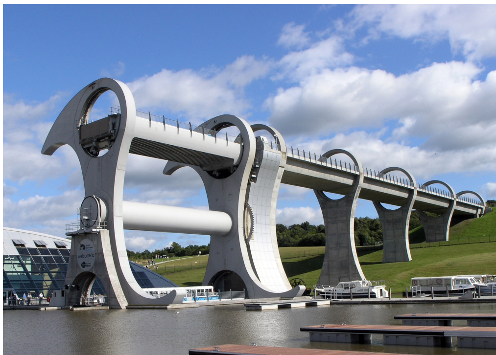
Rys. 4.21. Falkirk Wheel – podnośnia obrotowa o wysokości 35 m ( www.scottishcanals.co.uk )
