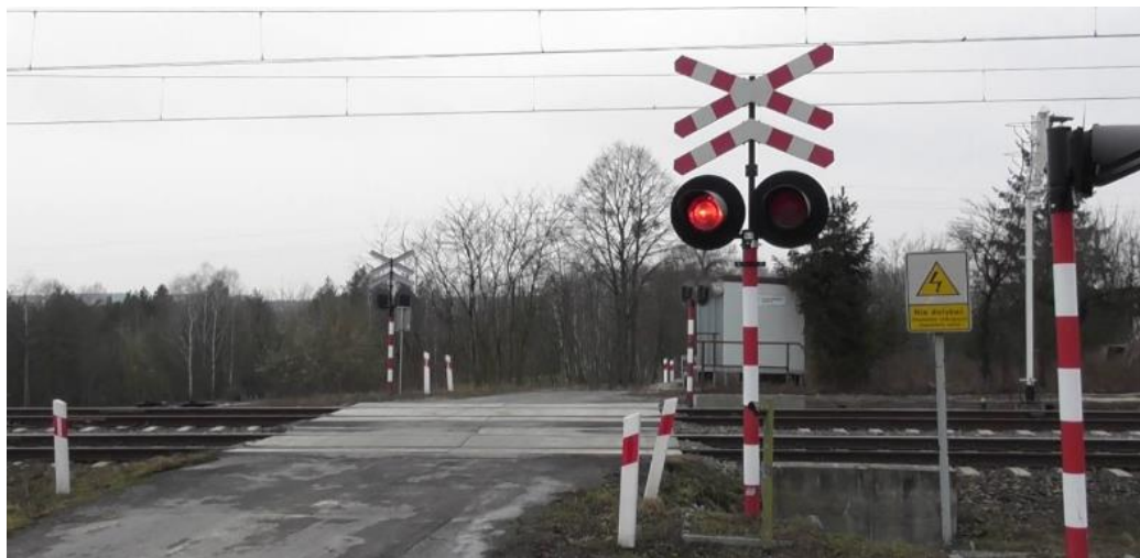
Rysunek 9. Przejazd kat. C zabezpieczony sygnalizacją
