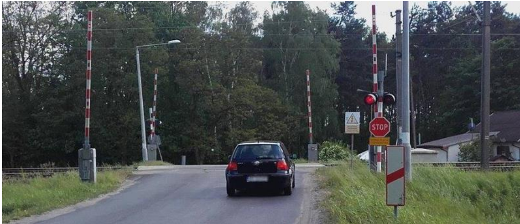
Rysunek 7. Przejazd kat. B zabezpieczony rogatekami i sygnalizacją
