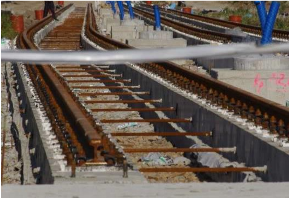
Rysunek 10. Tor zielony w technologii Moll podczas budowy, Kraków, trasa tramwajowa na Ruczaj Źródło: [15]
