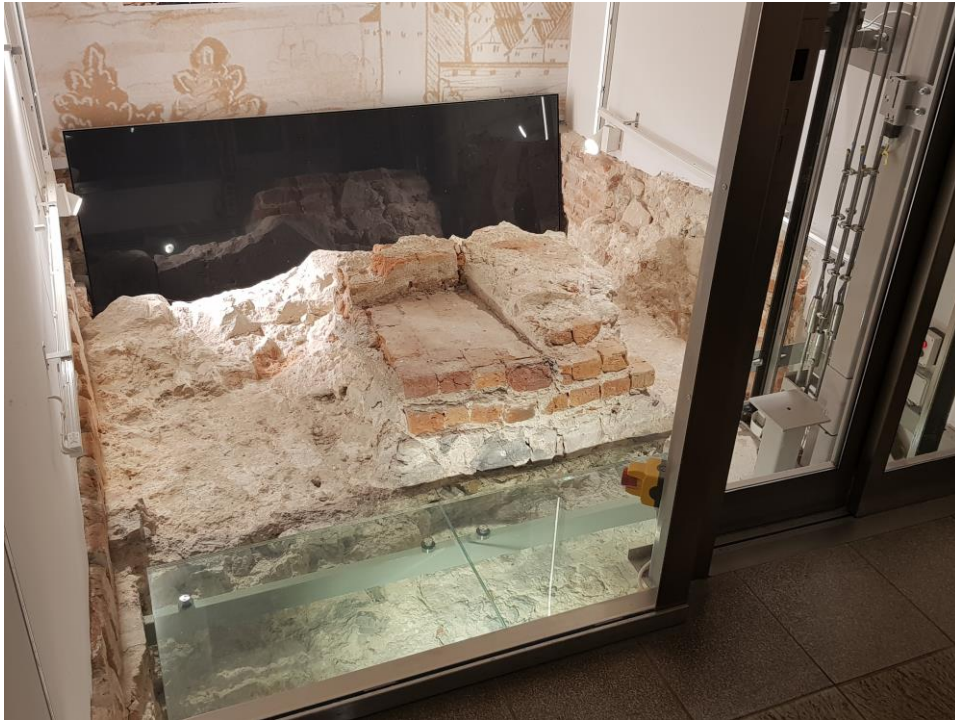
Ilustracja 7 Widok na zrealizowany szymb windowy z odsłoniętymi podczas prac archeologicznych relikwiami murów magistralnych z poprzednich faz architektonicznych pałacu, projekt aranżacji dr Katarzyna Kołodziejczyk, fot. Piotr Pikulski
