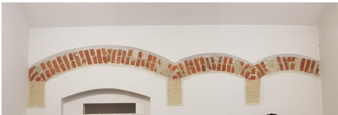
Ilustracja 37 Elementy murowanych łuków w dzisiejszej szatni budynku WA PK, dawnym pałacu w Łobzowie, fot. Piotr Pikulski
