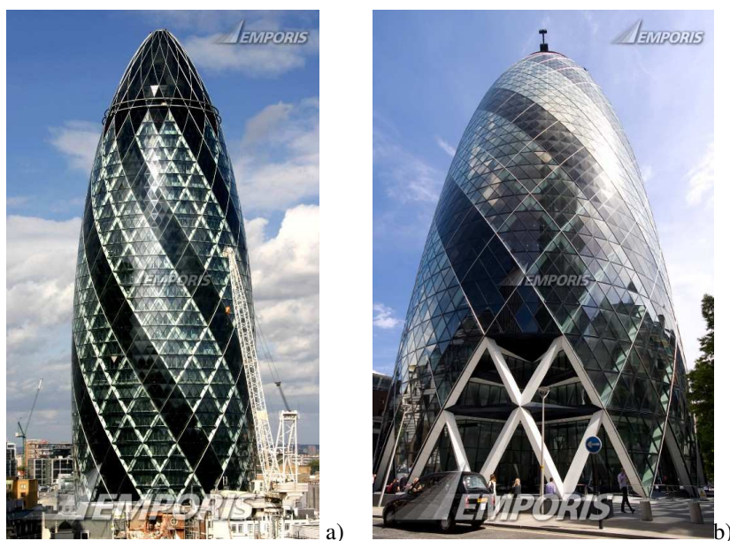
Rys. 4.6.6 a i b Budynek 30 St Mary Axe. widok elewacji budynku (a, b)
