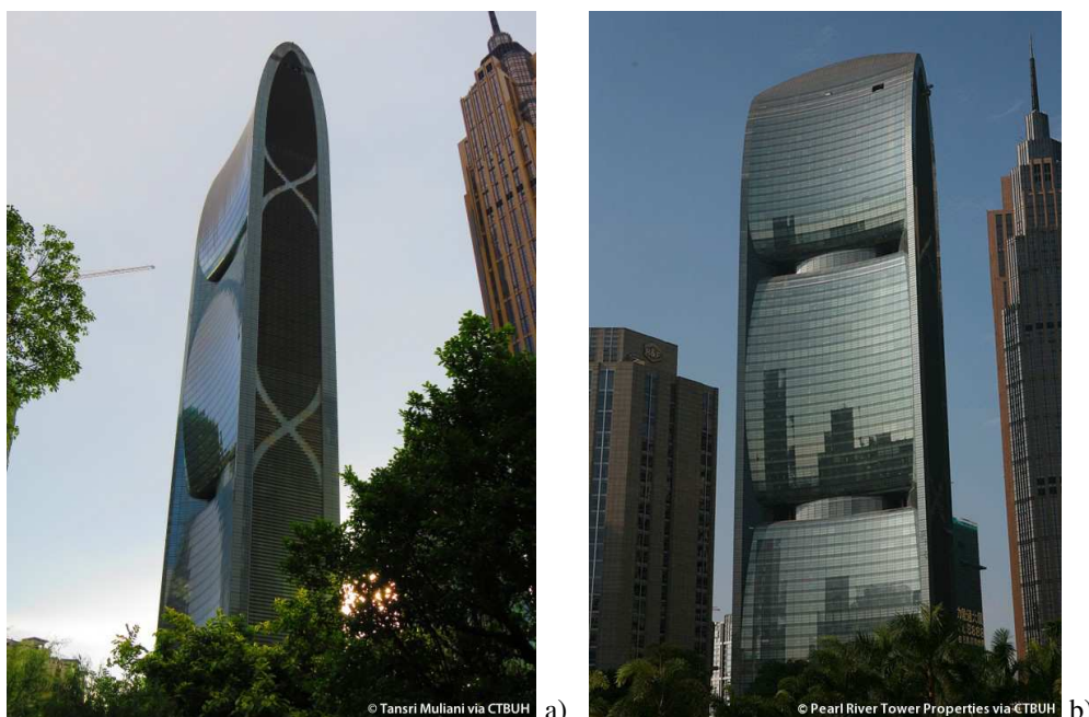
Rys. 3.8.5 a i b Budynek Pearl River w Guangzhou w Chinach widok elewacji
