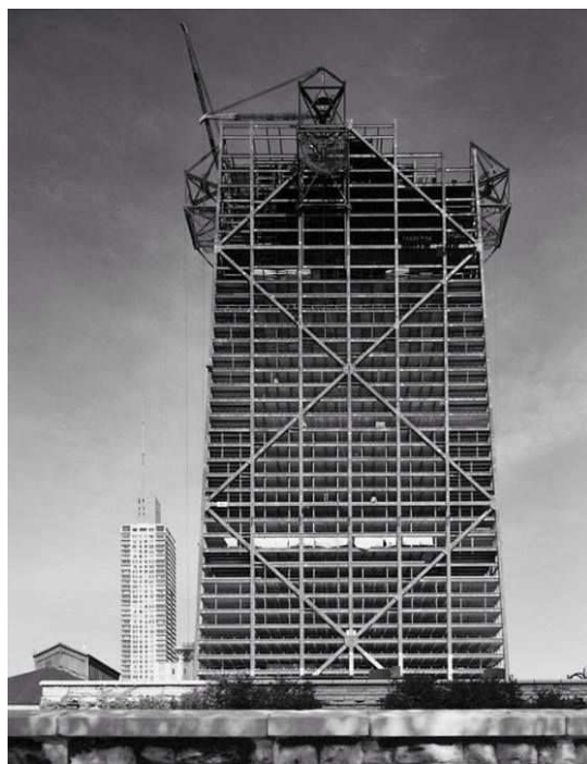
Rys. 4.6.5 a i b Stalowa konstrukcja budynku JHC w Chicago Źródło: [i14]
