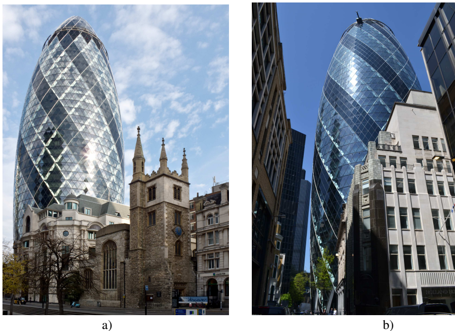
Rys. 3.2.7 a i b Budynek Swiss Re w Londynie w ścisłej zabudowie historycznej Londynu (a) Źródło: [i36] oraz (b) fotografia autorska dr inż. S. Jurczakiewicz
