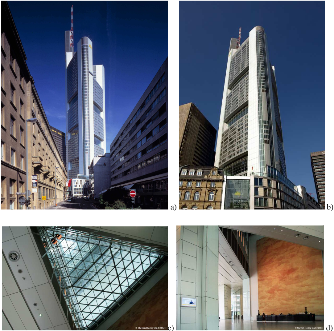
Rys. 4.4.10 Budynek Commerzbank. (a, b) widok elewacji wraz widocznym podziałem zgeometryzowanej elewacji. (c) widok na przeszklone wewnętrzne atrium. (d) widok odzwierciedlający wielkość przestrzeni we strefie wejściowej
