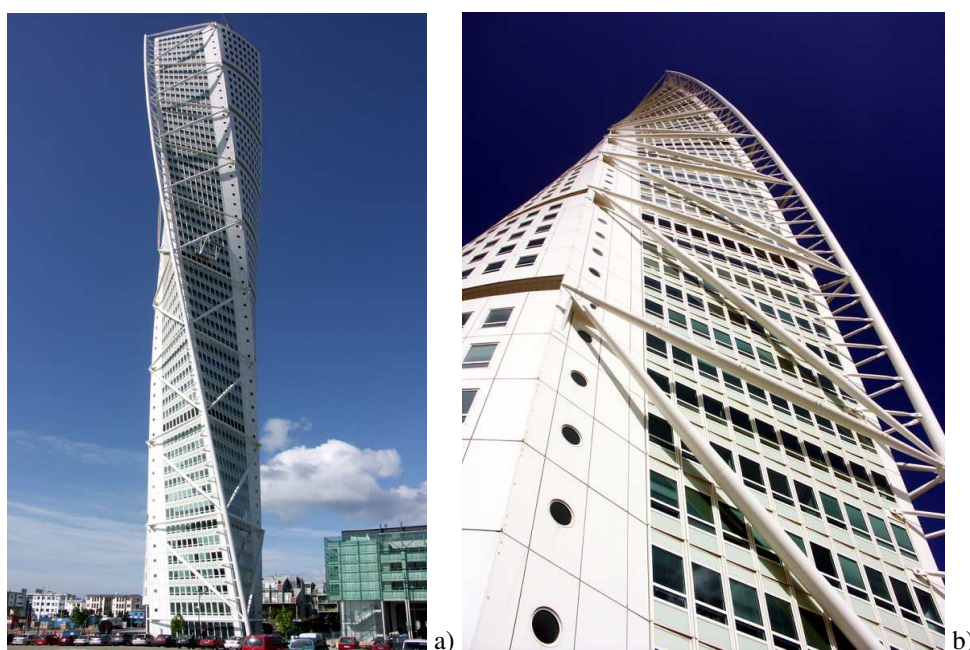
Rys. 4.4.14 a i b Budynek Turning Torso w Malmo (Szwecja) (a) widok elewacji budynku (b) zbliżenie na układ skratowań w linii elewacji
