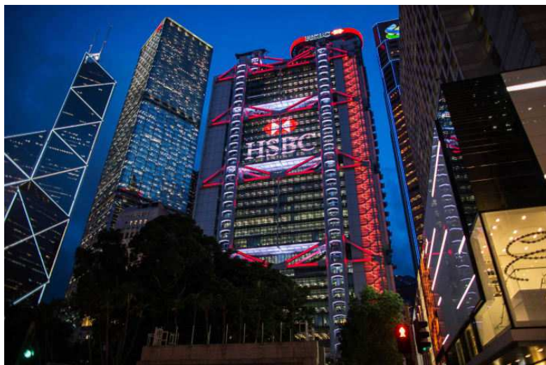
Rys. 3.2.13 Panorama sąsiedztwa budynków Bank od China i HSBC Źródło: [i1]
