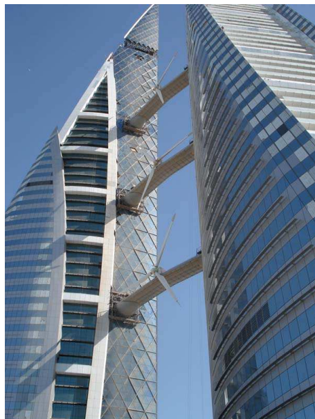
Rys. 3.8.9 Turbiny wiatrowe w budynku Bahrain World Trade Center Źródło: [i1]
