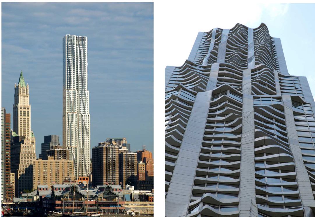
Rys. 3.3.5 a i b Budynek Eight Spruce Street w Nowym Jorku Źródło: [i1]
