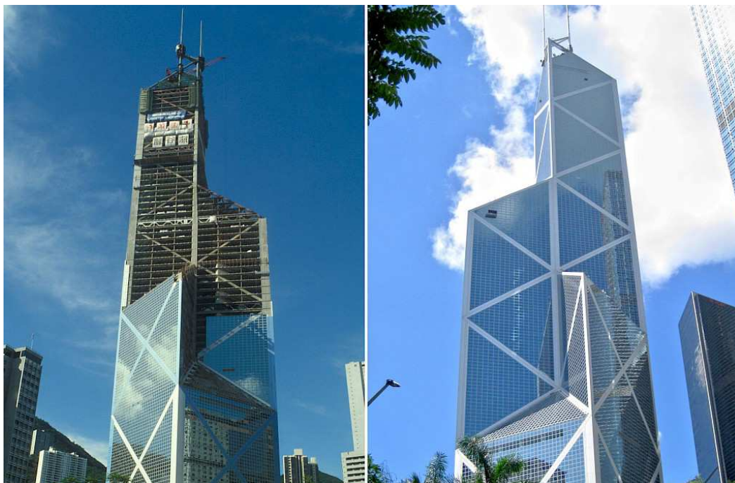
Rys. 4.8.21 a i b Budynek Bank of China w trakcie realizacji (lewa fotografia) oraz wygląd ostateczny (prawa fotografia)
