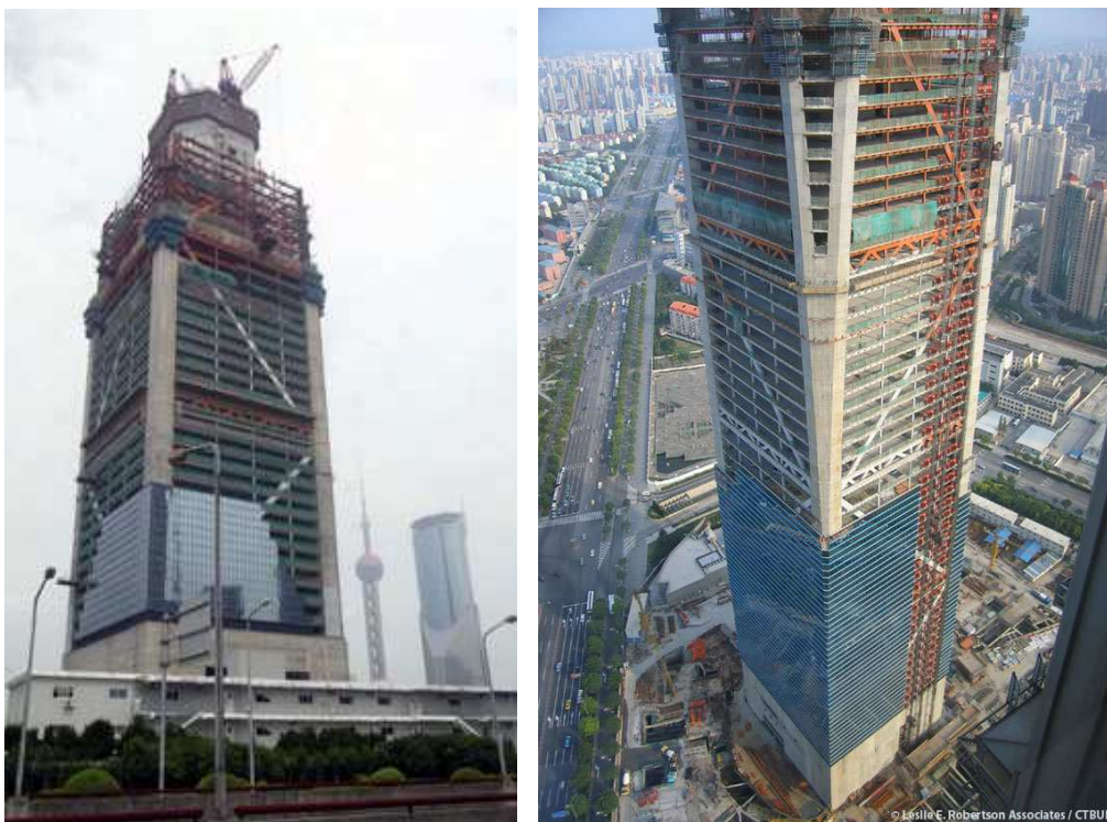
Rys. 4.8.10 Skratowania w linii elewacji budynku SWFC Źródło: [i21]
