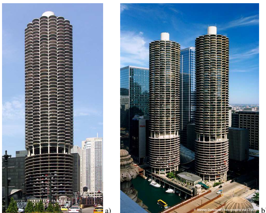
Rys. 4.4.13 a i b Budynki Marina City 1 i 2 w Chicago, widok elewacji budynku (a,b)
