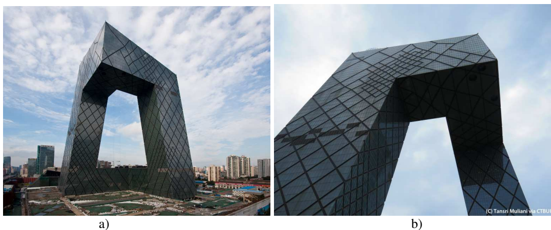
Rys. 4.6.8 a i b Budynek CCTV w Pekinie (Chiny) Źródło: [i1]
