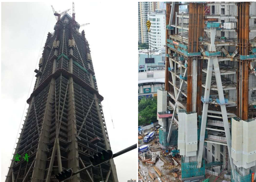
a) b) Rys. 4.8.14 a i b Konstrukcja budynku Ping An Finance Center Źródło: [116]
