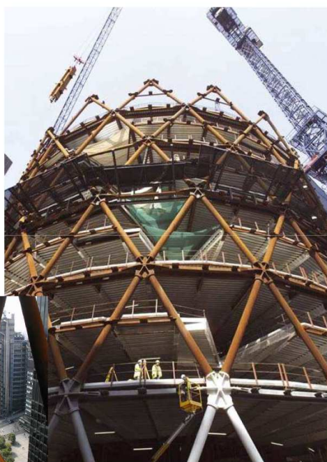
Rys. 4.6.7 c Powłoka stalowa Swiss Re wraz z detalem węzła skratowań Źródło: [i1]
