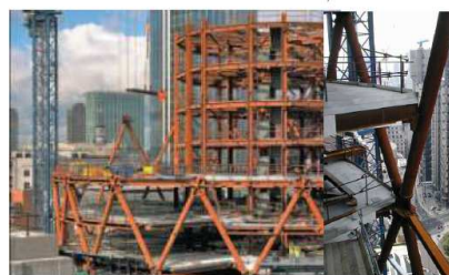
Rys. 4.6.7 c Powłoka stalowa Swiss Re wraz z detalem węzła skratowań Źródło: [i1]
