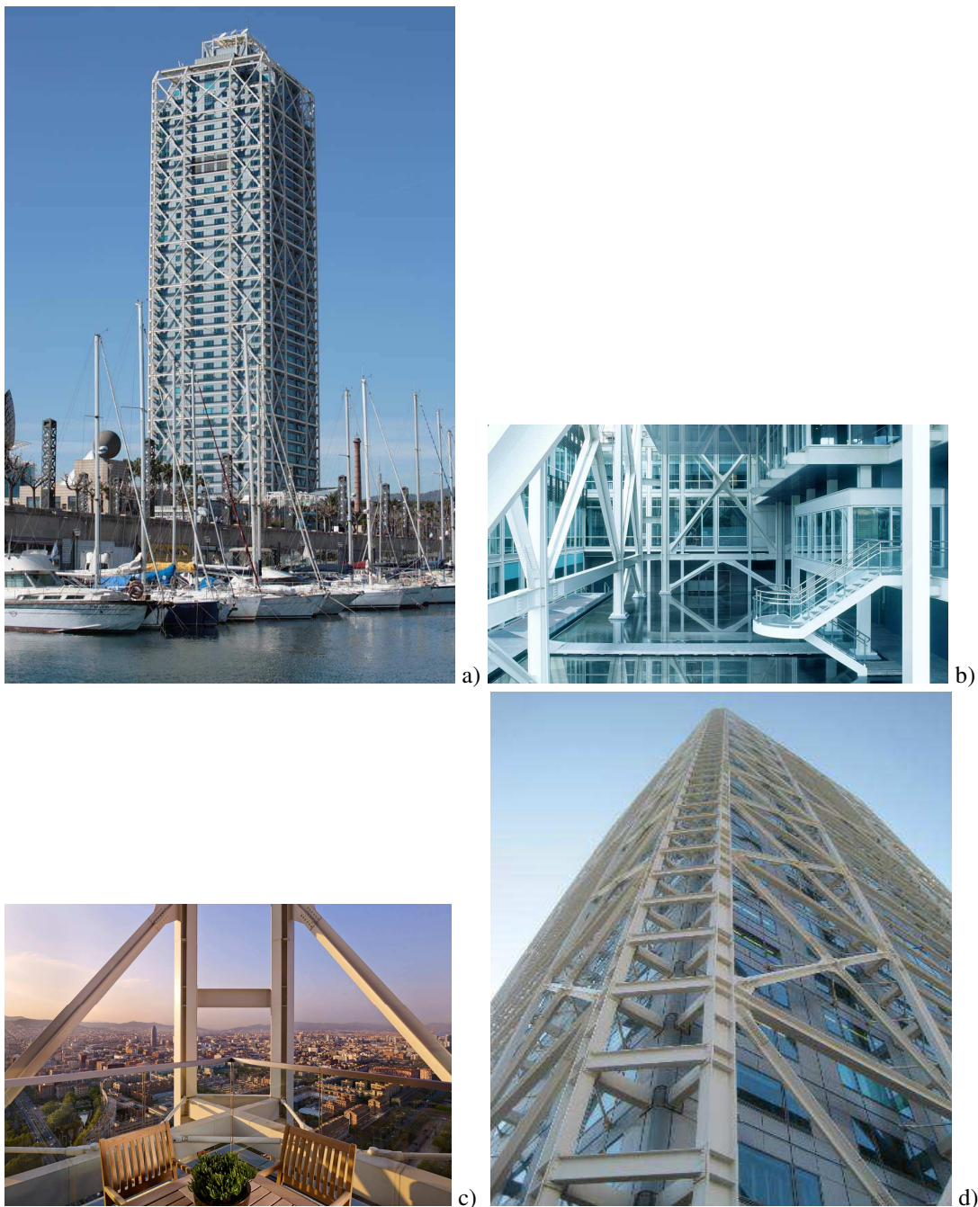
Rys. 4.3.10 a, b, c, d Widok stalowej ramy zewnętrznej na elewacji budynku (a, c, d) oraz uzyskana przestrzeń za ustrojem nośnym (b)
