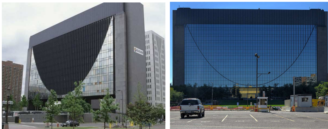
Rys. 4.5.7 Widok elewacji budynku Marquette Plaza (dawny budynek banku Rezerw Federalnych.) Źródło: [i43]
