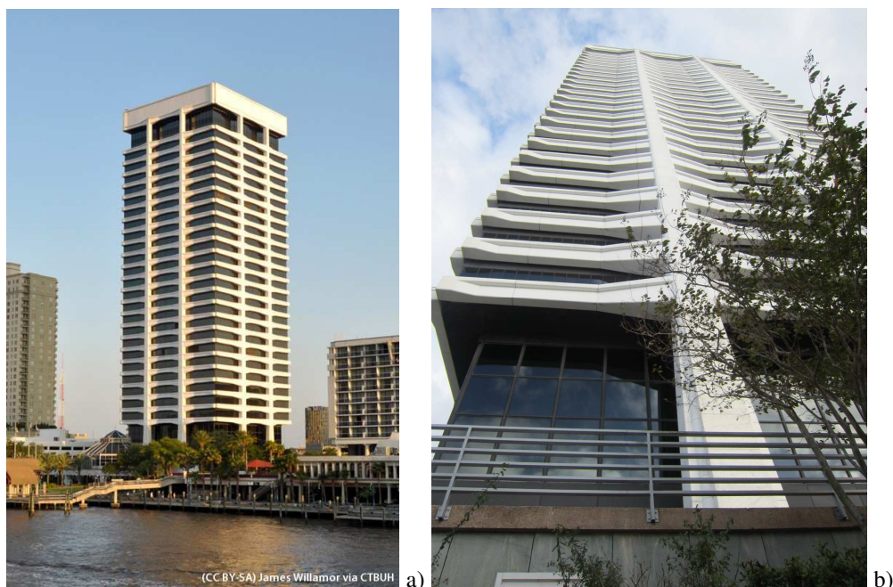
Rys. 4.3.4 a i b Widok elewacji budynku Riverplace Tower (a) zbliżenie na układ nośny ramowy (b)
