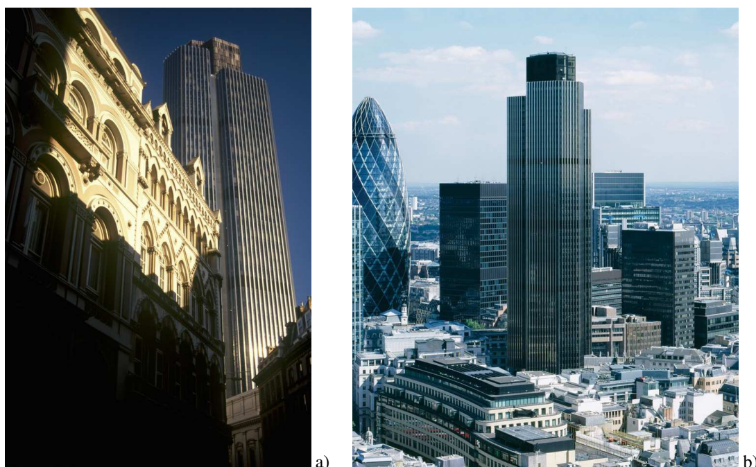
Rys. 4.4.4 a i b Budynek Tower 42 (a, b) widok elewacji budynku
