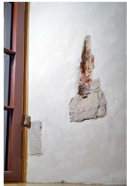
Ryc. 7. Na pierwszym planie średniowieczne kamienne gniazdo z wyłobieniem służące do blokowania belką okiennicy. W głębi – nowożytny hak po okiennicy wzmocniony kamiennym blokiem. Fot. D. Kula, 2017
