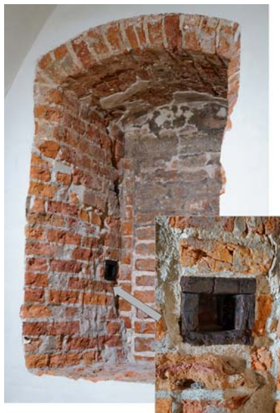
Ryc. 6. Gniazdo w ościeżu okna (wyłożone drewnianymi deskami) po belce służącej do blokowania okiennicy. Fot. D. Kula, 2017
