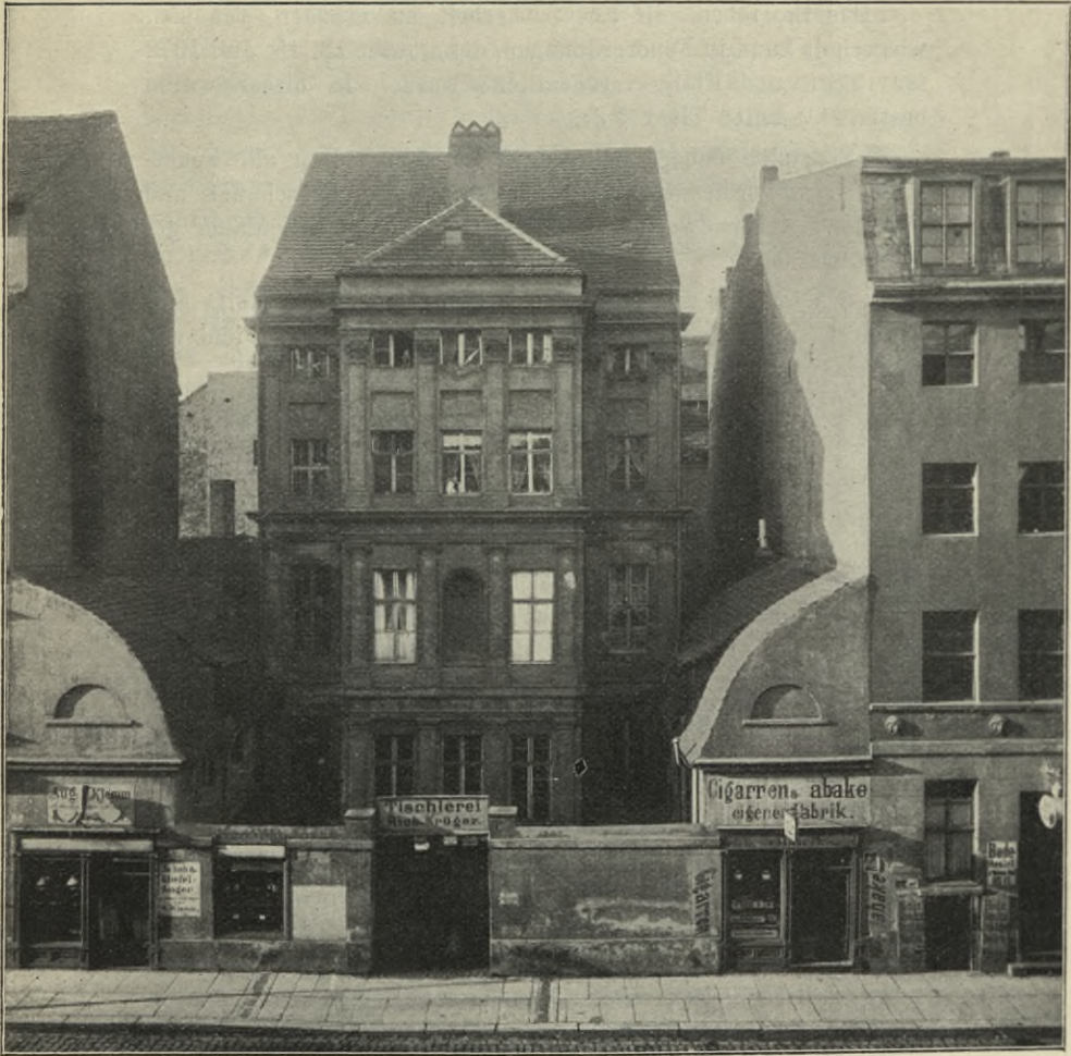
Abb. 24. Wallstr. 72 (abgerissen) Nach einer Photographie von F. Albert Schwartz, Berlin NW 87
