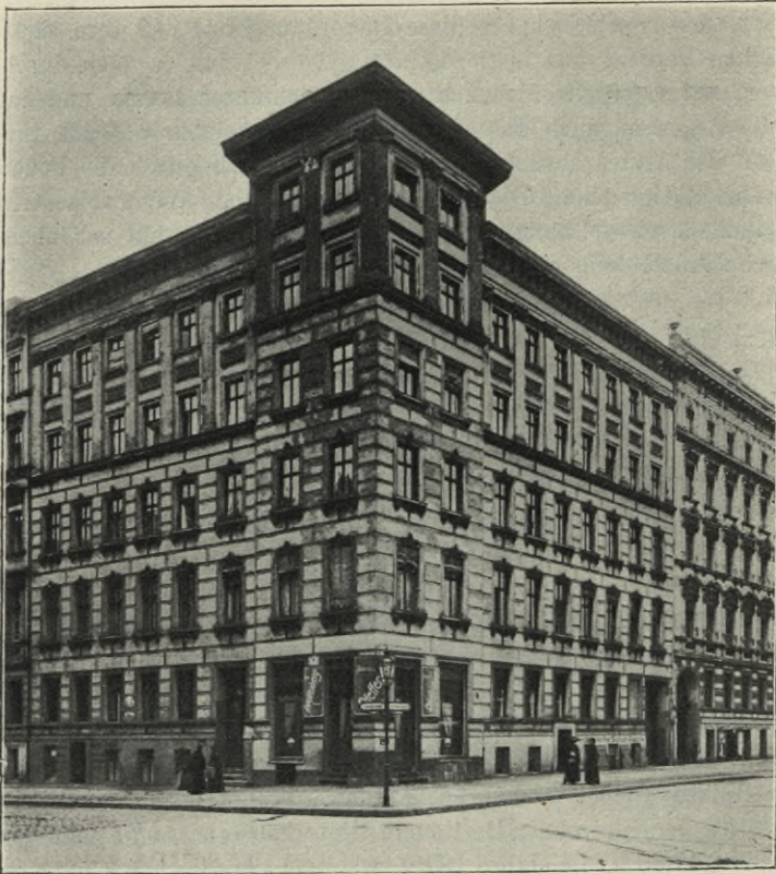
Abb 44. 6 und 7stöckige Mietkasernen. Zionskirchstraße
