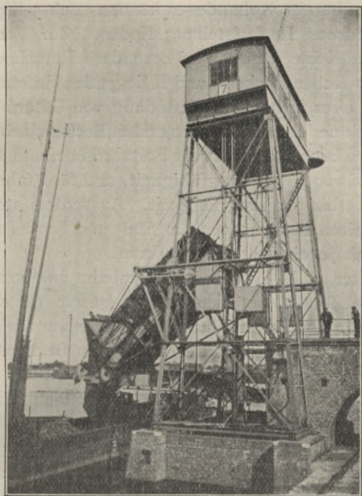
Elektrischer Kohlenkipper im Hafen zu Cosel.
