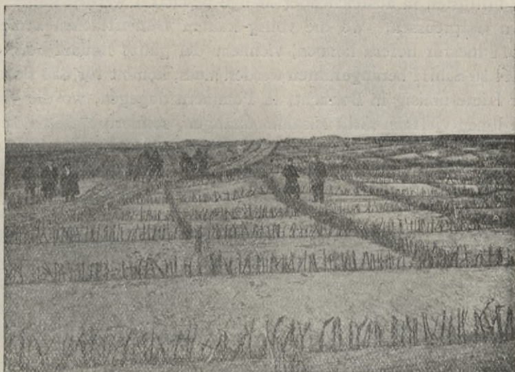
Kiefernbesteck zur Festlegung der Wanderdünen zwischen Süderspitze und Schwarzort.
