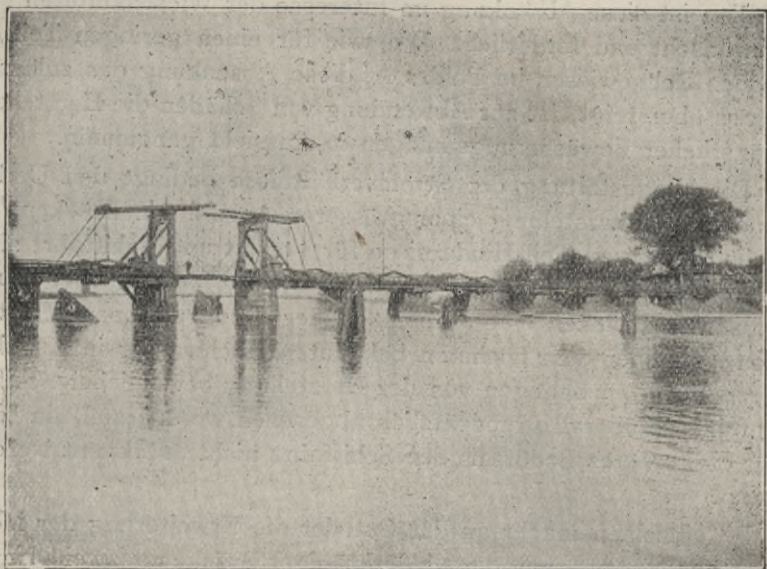
Alte Oderbrücke bei Mescherin.
