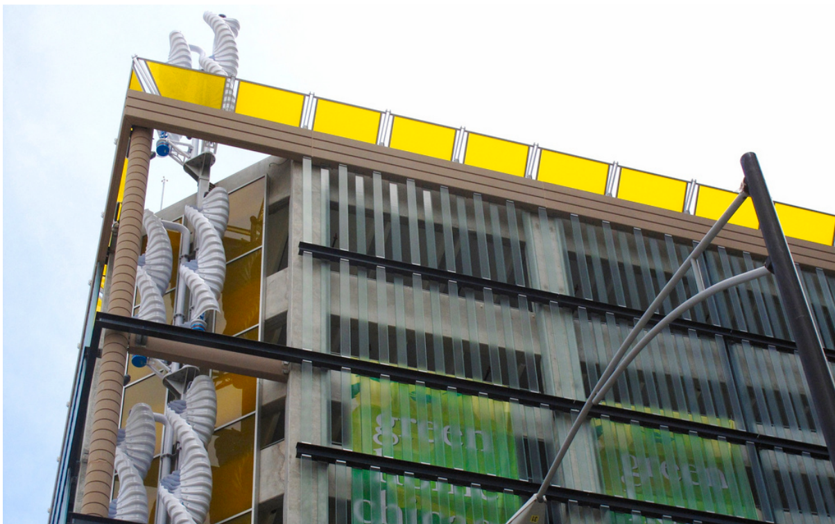
Il. 3.6 Greenway Self Park, Chicago, Stany Zjednoczone, źródło: https://www.archdaily.com/74468/greenway-self-park-hok/turbine3 , dostęp: 06-03-2019.
