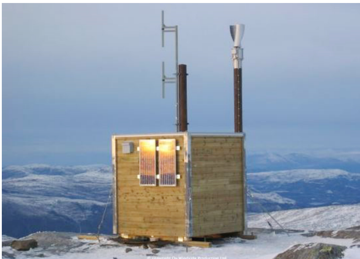
Il. 4.4 Turbina Windside WS – 0,15 B zainstalowana na posterunku policyjnym w Norwegii, źródło: http://www.windside.com/products/ws-0_15 , dostęp: 24-08-2017.
