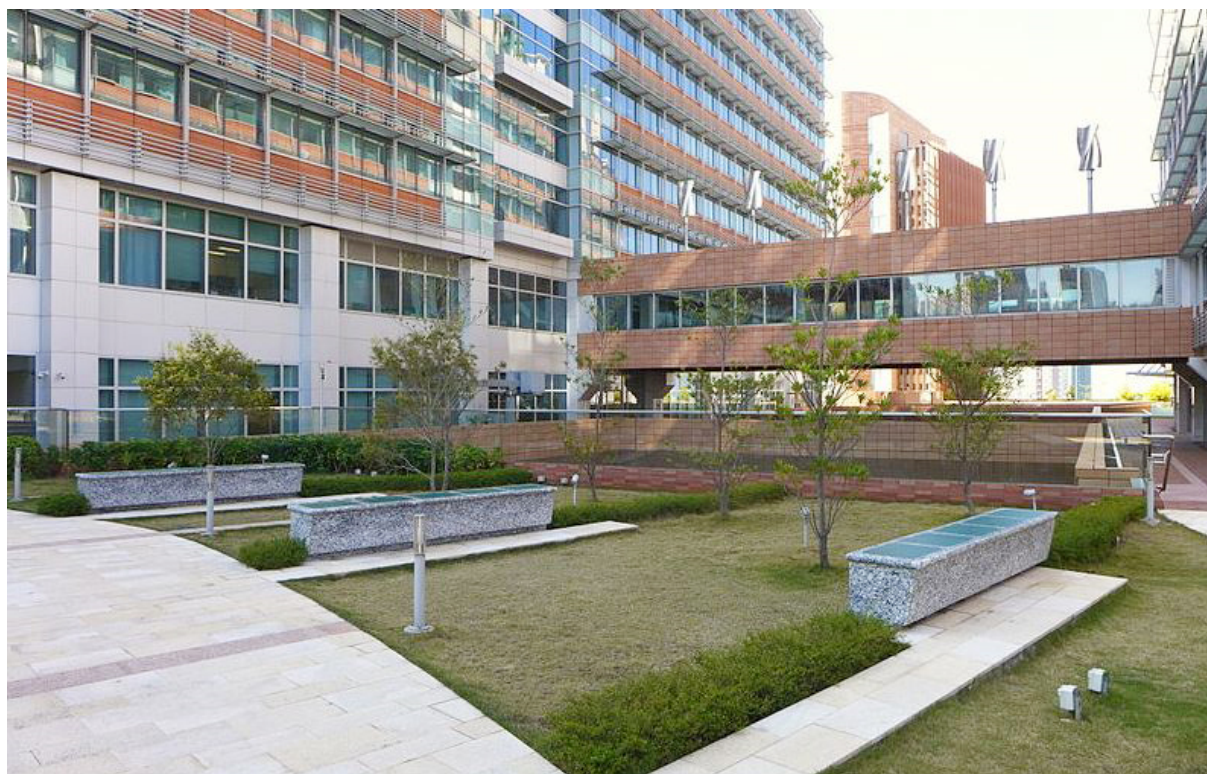
Il. 5.58 Źródło: https://commons.wikimedia.org/wiki/File:HKU_Centennial_Campus_L3_Podium_201412.jpg , dostęp: 03-08-2018.
