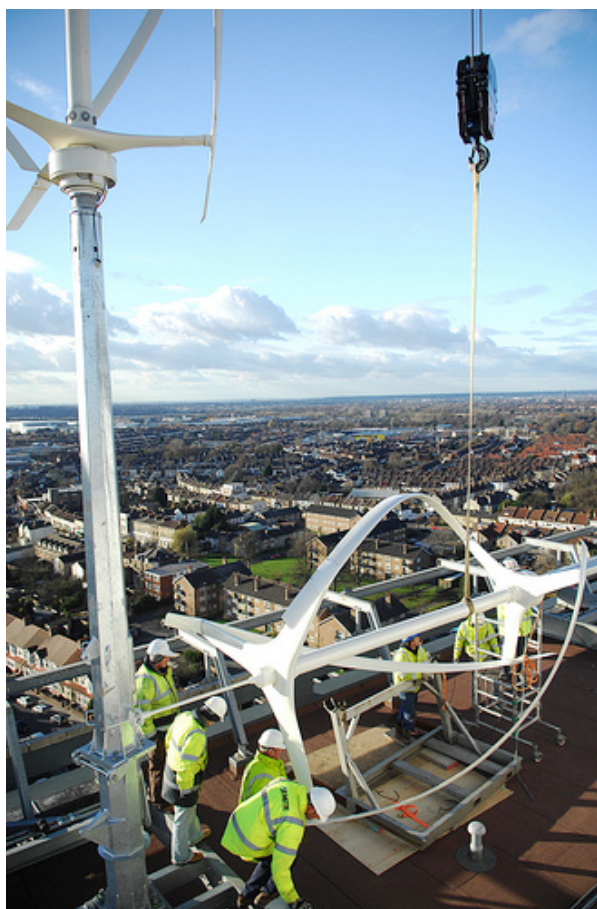
Il. 4.2 Turbina w trakcie instalacji na dachu, źródło: www.quietrevolution.com , dostęp: 24-08-2017.
