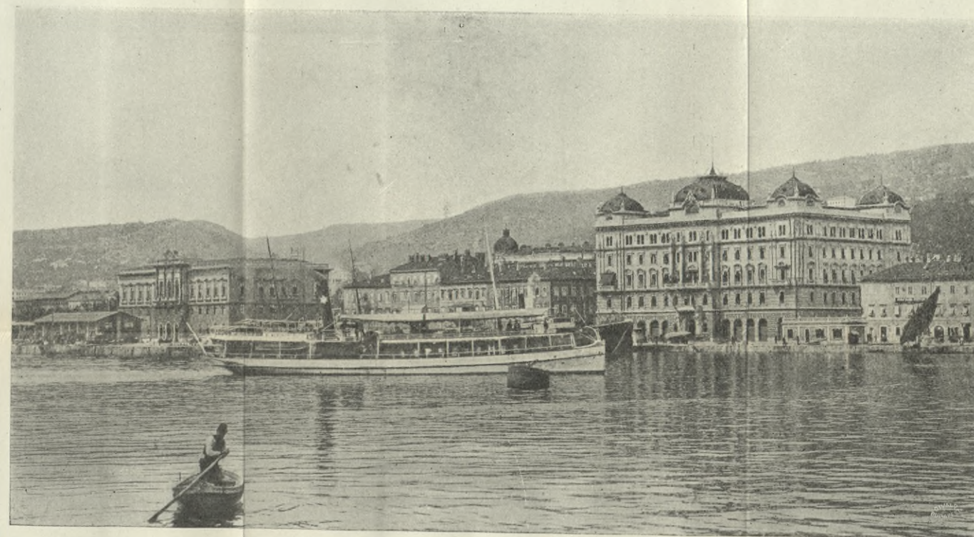
Palais de l'Office maritime. Palais de la Société de Navigation « Adria ». Fig. 4. — Les quais Sanita et Szápáry.
