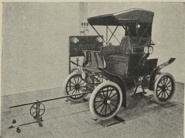
Fig. 187. Bakers Einrichtung zum Ausprobieren der Reifen.
