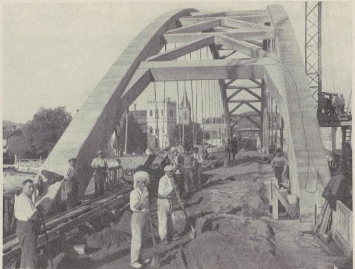
Abb. 11. Probelastung mit Sand.
