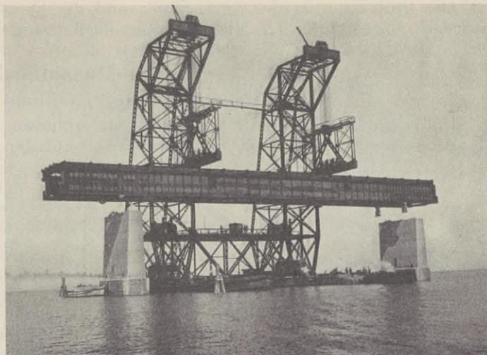
Abb. 25. Schwimmkran mit 500 t Tragfähigkeit.
