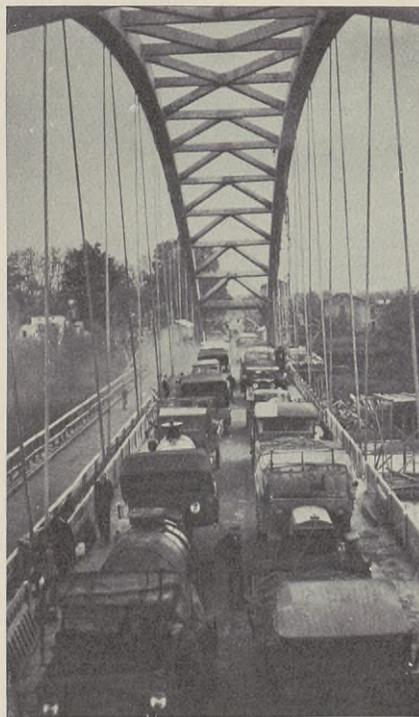
Abb. 12. Probelastung mit beweglicher Last.
