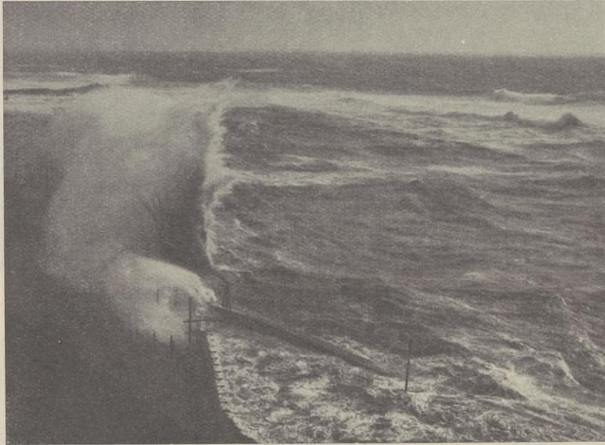
Abb. 38. Brecher an der Westmole des Marinehafens bei HHW und Nordwest Stärke 12, vom Oberland aus aufgenommen. Höhe des Brechers über dem Wasserspiegel 31 m.
