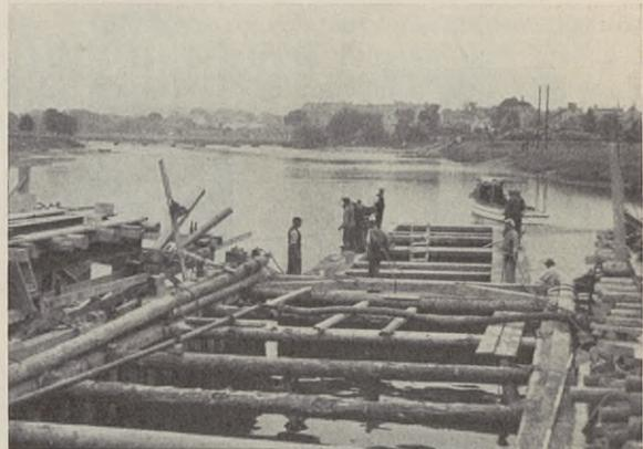
Abb. 37. Ausschwimmen eines im Docksenkkasten hergestellten Senkkastens (Regen-Brücke Regensburg, vgl. Abb. 1).
