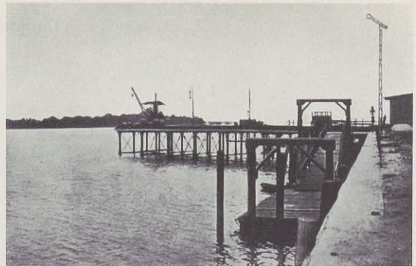
Abb. 33. Kai und alte Schraubpfahlbrücke.
