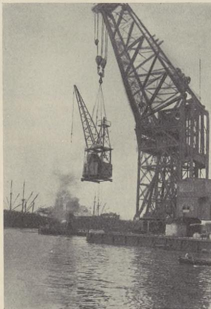
Abb. 18. 150 t-Schwimmkran beim Umsetzen von Kaikränen.
