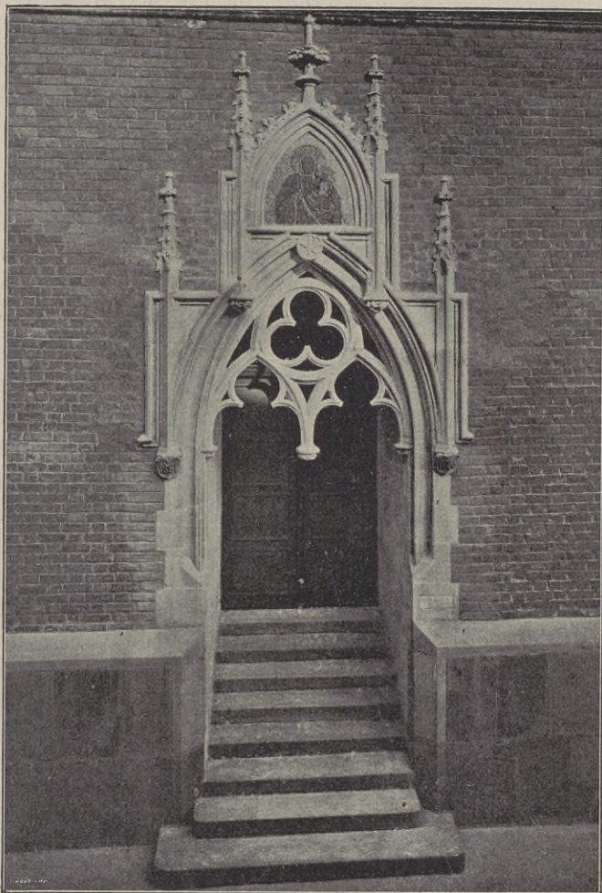
PORTAL WIEŻY KOŚCIOŁA KATEDRALNEGO
