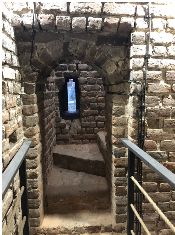
Ryc. 9. Zamek Górny, wieża bramna, poziom piwnic, wejście na schody z pomieszczenia przeciwwagi mostu zwodzonego, fot. A. Legendziewicz
