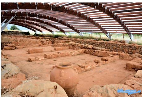
Ryc. 7. Osłona o drewnianej konstrukcji rozpięta nad reliktywami pałacu minojskiego w Malii na Krecie, przykład prawidłowych rozwiązań stosowanych do panujących warunków klimatycznych i specyfiki materiału zabytkowego (cegła suszona), źródło: E. Danzi, Metodologie di indagine. La schedatura delle coperture archeologiche: alcune riflessioni sull'impostazione metodologica del progetto , [w:] Archeologia e Contemporaneo , (red.) A. Indrigo i A. Pedersoli, Università luav di Venezia, luav 81, Venezia 2010
