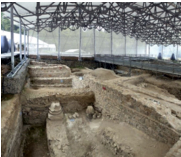
Ryc. 4. Osłona relikwii na stanowisku archeologicznym w Bibracte, pokrycie wykonane z tkaniny z włókna szklanego, wodoodporne, nie przepuszcza promieniowania UV, wyjmowane pionowe elementy tekstylne pomagają regulować klimat wewnętrzny. Źródło: Stefanos Koufopoulos, https://repository.tudelft.nl
