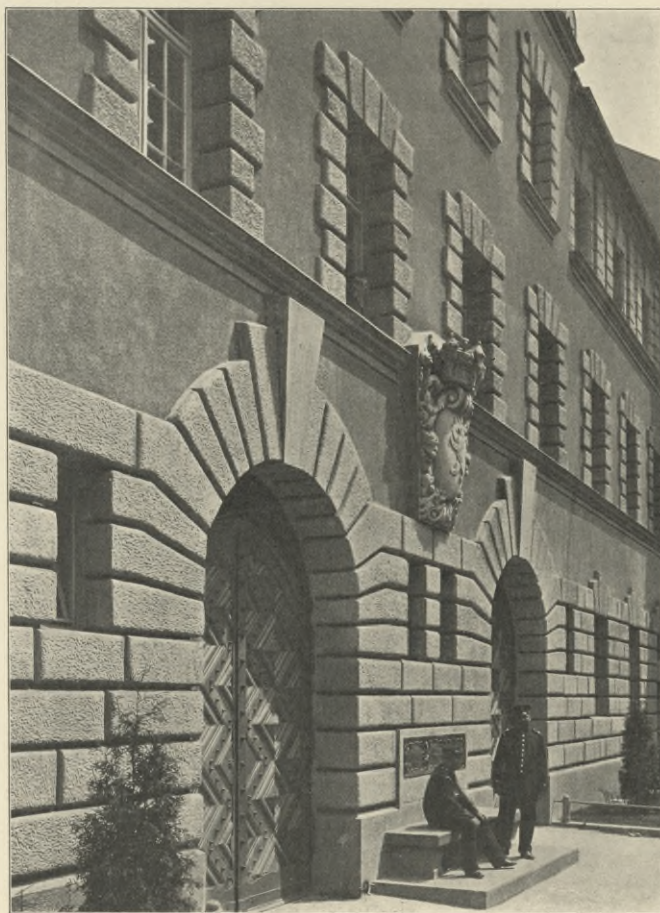
Abb. 37. (Mittlerer Teil der Fassade der Feuerwache.)
