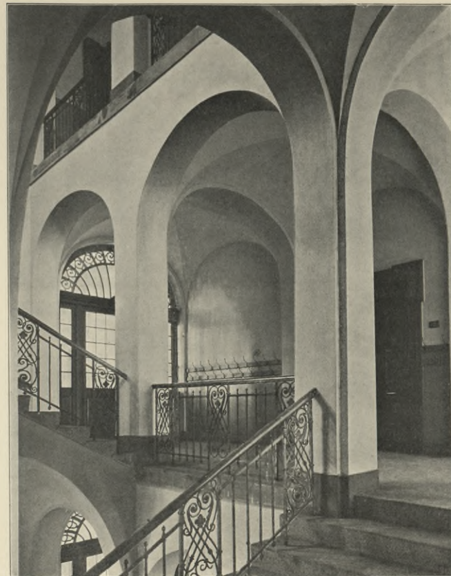
Abb. 32. (Treppenhaus im Schulgebäude.)
