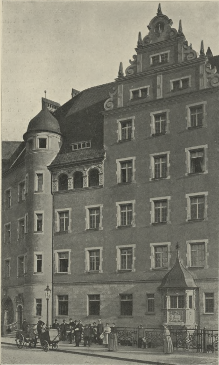
Abb. 43. (Fassade des Standesamts.)
