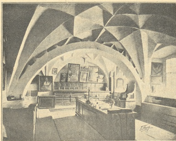
Fig. 170. Sklepienie gotyckie kryształowe zakrystyi kościoła św. Anny w Wilnie.
