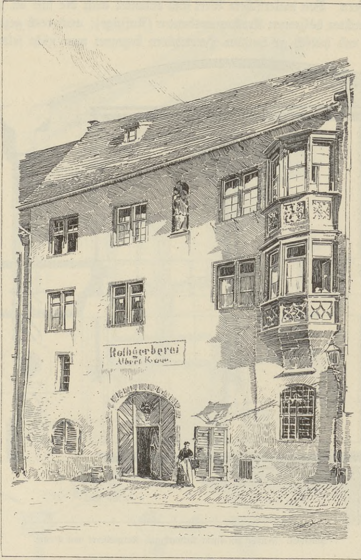
Rottweil. Privathaus (Koblererei von Kiene).
