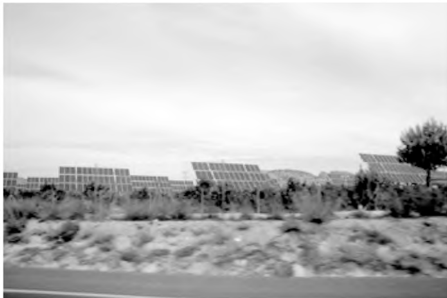
Panele baterii słonecznych w Hiszpanii
