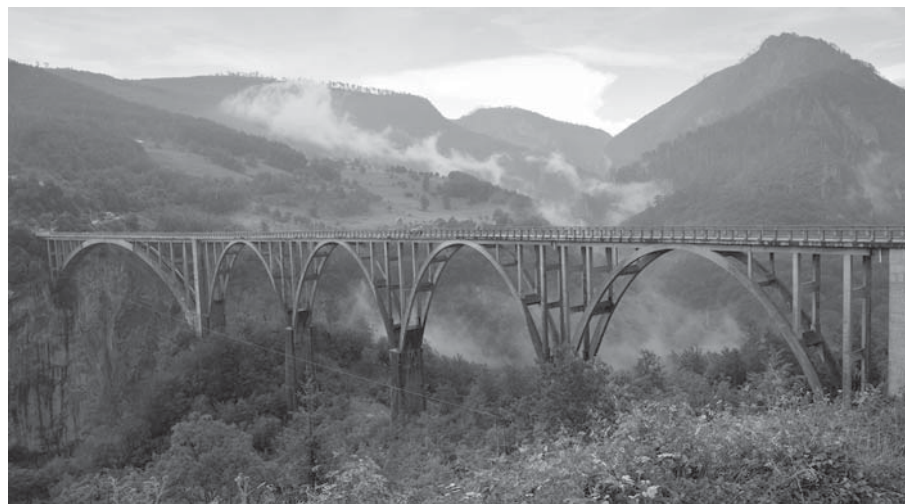
Żelbetowy most nad wąwozem rzeki Tary w Czarnogórze
