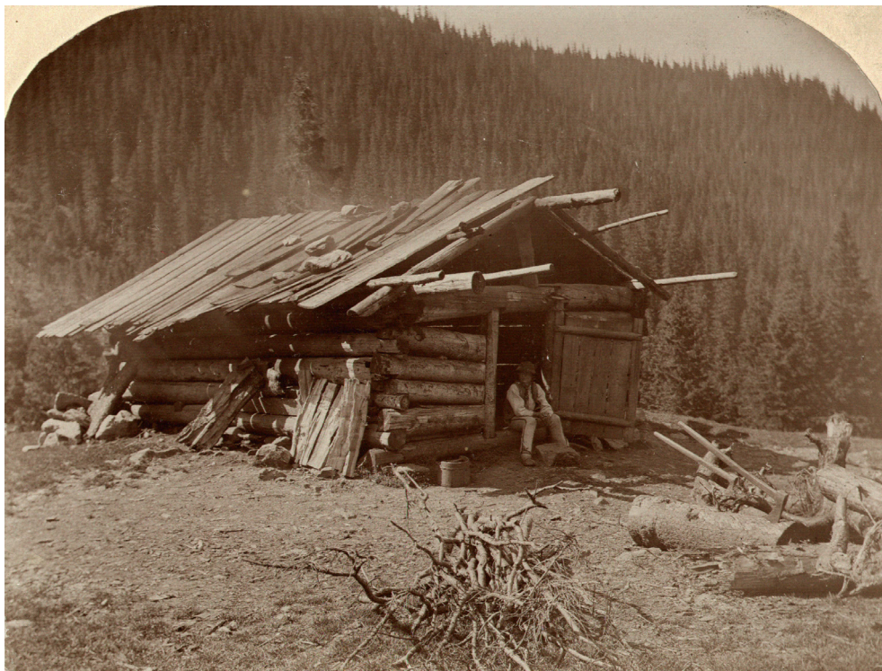
Il. 1. Bacówka niskozrębowa z dachem półsochowym na Hali Pyszej. Fot. Walery Eljasz, 1896. Tatrzański Park Narodowy, Ośrodek Dokumentacji Tatrzańskiej, Zbiory Paryskich
