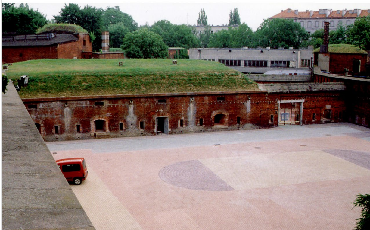
Ryc. 3. Plac wielofunkcyjny oraz kaponiera szyjowa Bastionu III „Kleparz” adaptowana na klub muzyczny; izolacja budynku wykonana bez zdejmowania nasypów na kazamatach w latach 2004–2006; fot. i rys. K. Wielgus.
