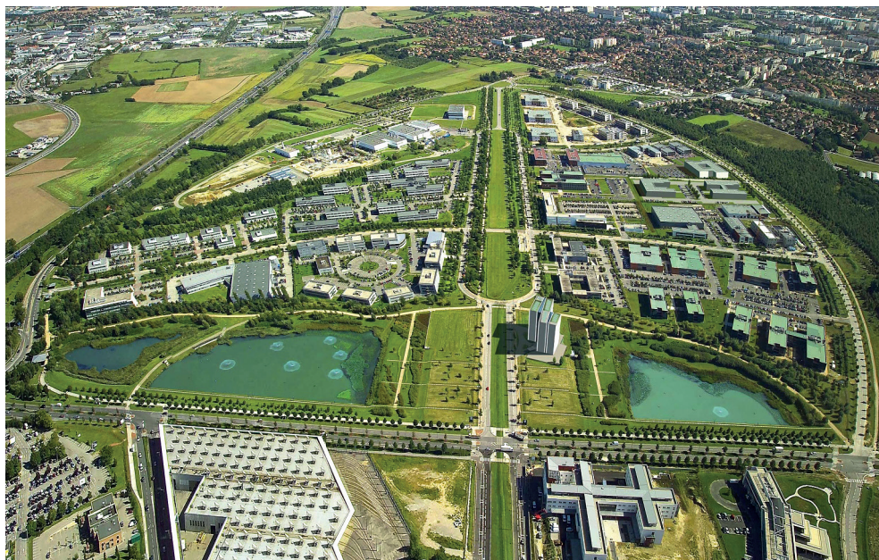
Il. 47. Widok z lotu ptaka na Park Technologiczny w Lyonie – w części centralnej w paśmie zieleni stanowiącej oś założenia, mieści się linia tramwajowa wraz z przystankiem i ciągami pieszymi
