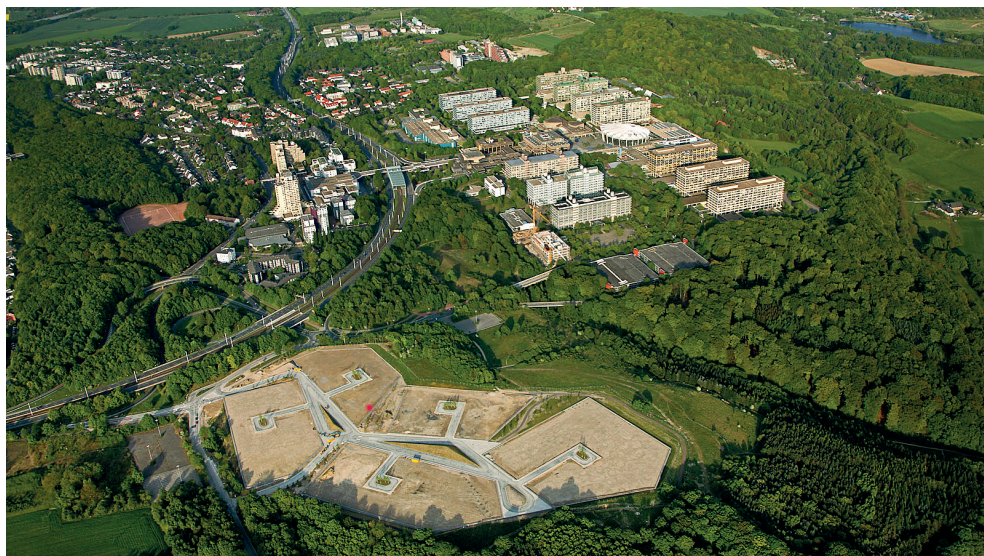
Il. 33. Ośrodki naukowo-technologiczne Bochum otoczone kompleksem zieleni chronionej. Z przodu teren przygotowany pod budowę obiektów BioMedizinPark (autor T. Schneider/ Schneider+Schumacher 2004-2007), dalej Kampus Uniwersytetu, w głębi u góry Technologie Quartier
