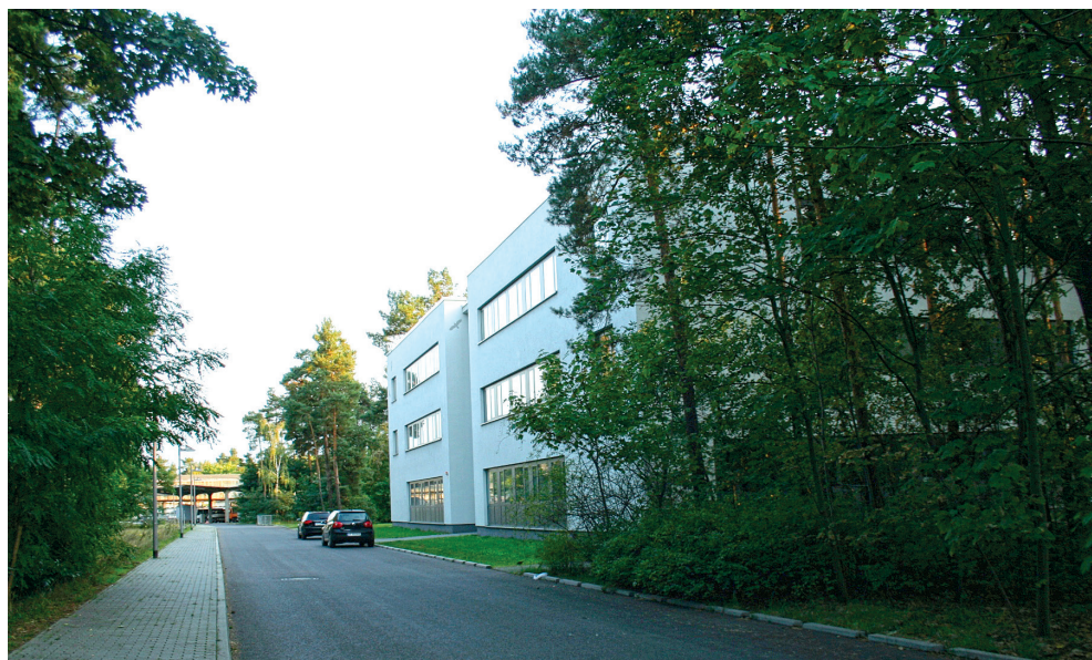
Il. 23. Ukryta w lesie zabudowa Wulheide Innovation Park w Berlinie tworzy odizolowany od zgiełku miasta ośrodek technologiczny w dawnym kompleksie rządowym
