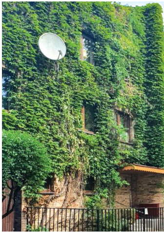
il. 1. Ściana budynku jednorodzinne w Warszawie porośnięta winoroślą. Zdjęcie J. Klimowicz 2019
