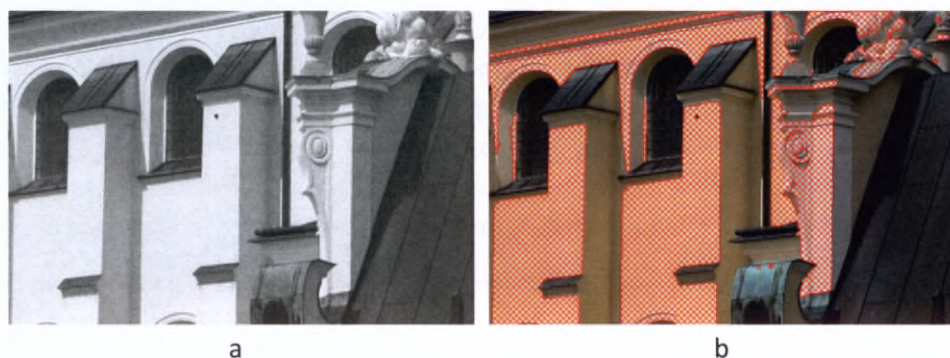
Il. 9.22. Składowa czerwona (a) oraz wynik detekcji muru nałożony na obraz początkowy (b)
