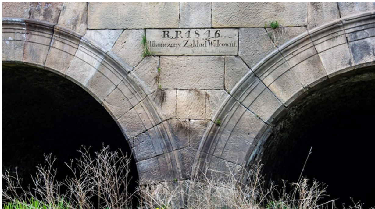
Ryc. 1. Walcownia huty żelaza w Nietulisku Dużym, fragment historycznego mostu z sygnaturą architekta Karola Knakego; https://roadtripbus.pl/nietulisko-duze-ruiny-walcowni .
