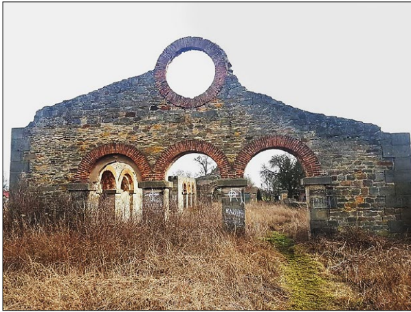
Ryc. 3. Walcownia huty żelaza w Nietulisku Dużym, widok ceglanych nadproży i dawnego naświetla, rok 2020; fot. M. Marchewka.
