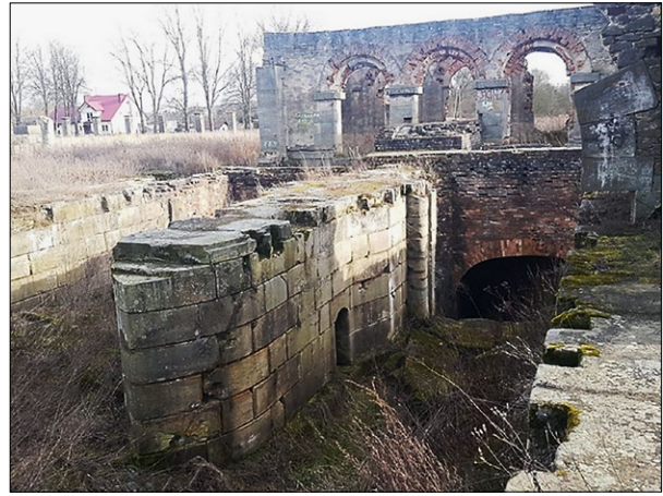
Ryc. 4. Walcownia huty żelaza w Nietulisku Dużym, rozprowadzenie zasilania wodnego do budynku walcowni z podziałem na dwa koryta zasilające, rok 2020; fot. M. Marchewka.
